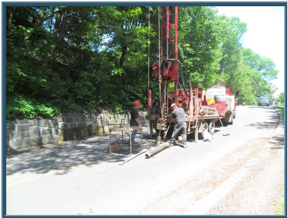
PHOTOGRAPHIE # 2: Foreuse en opération au sondage TF-02-11.
