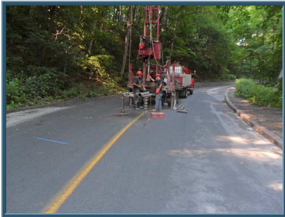
PHOTOGRAPHIE # 4: Foreuse en opération au sondage TF-04-11.
