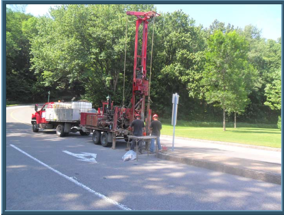
PHOTOGRAPHIE # 5: Foreuse en opération au sondage TF-05-11.
