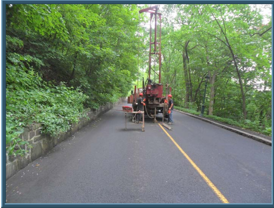
PHOTOGRAPHIE # 3: Foreuse en opération au sondage TF-03-11.
