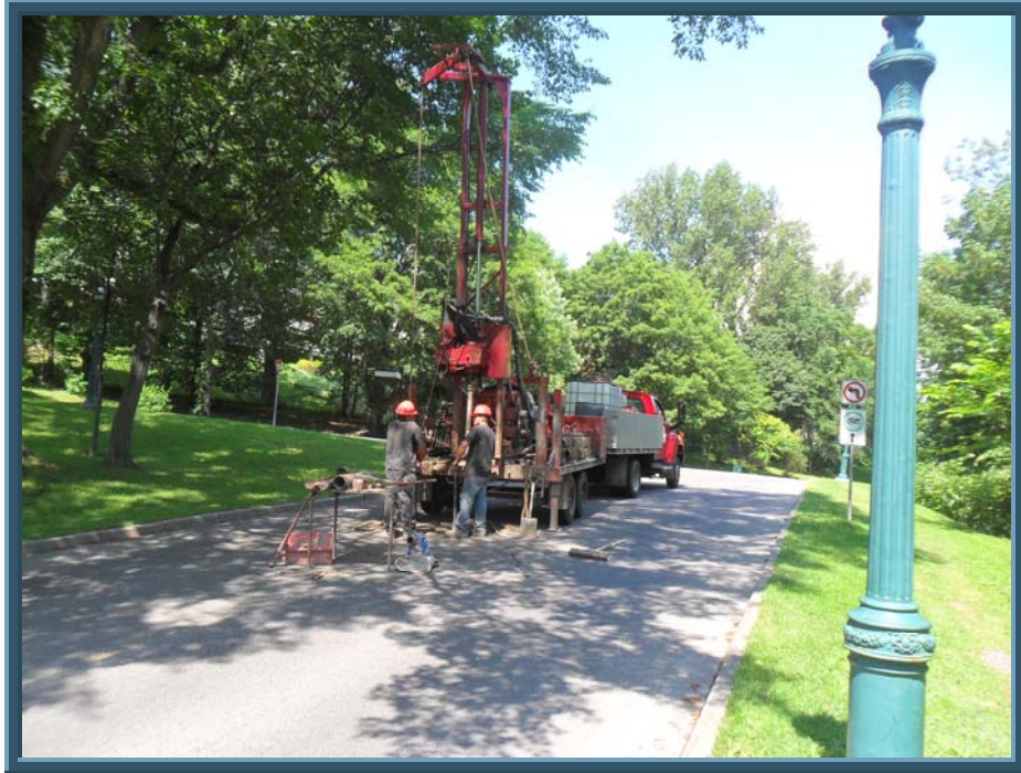
PHOTOGRAPHIE # 1: Foreuse en opération au sondage TF-01-11.
