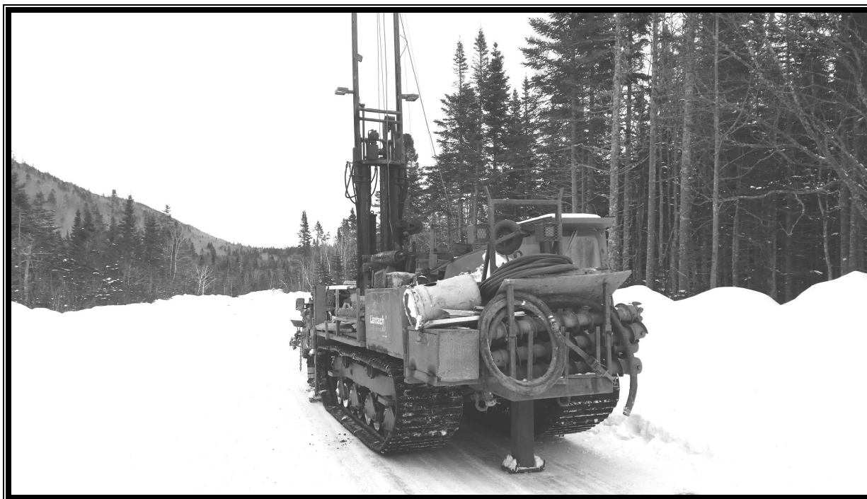
Photo 3 : Secteur de la route d'accès (TF-FV09-17, vue vers l'est)
