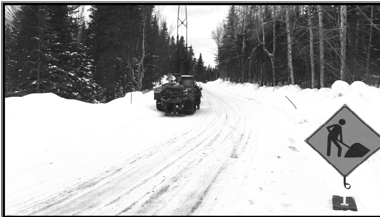
Photo 1 : Début de la route d'accès (TF-FV02-18, vue vers le nord)
