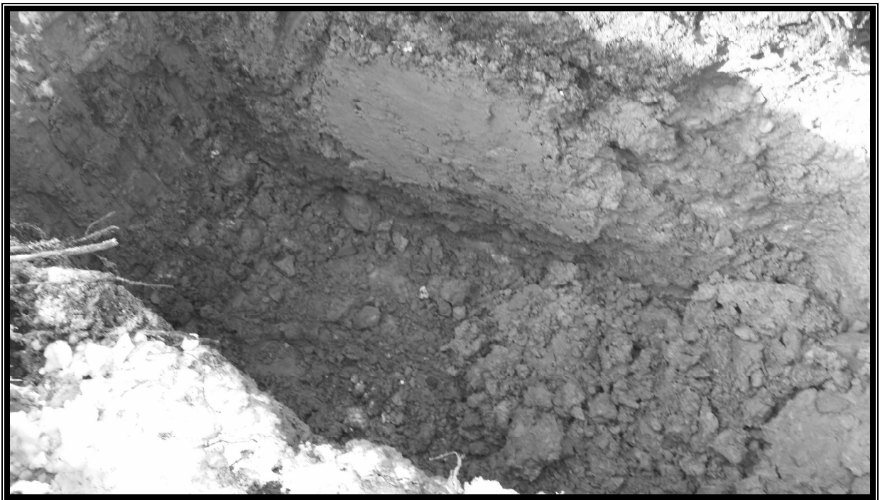
Photo 8 : Excavation du sondage PU-05-18
