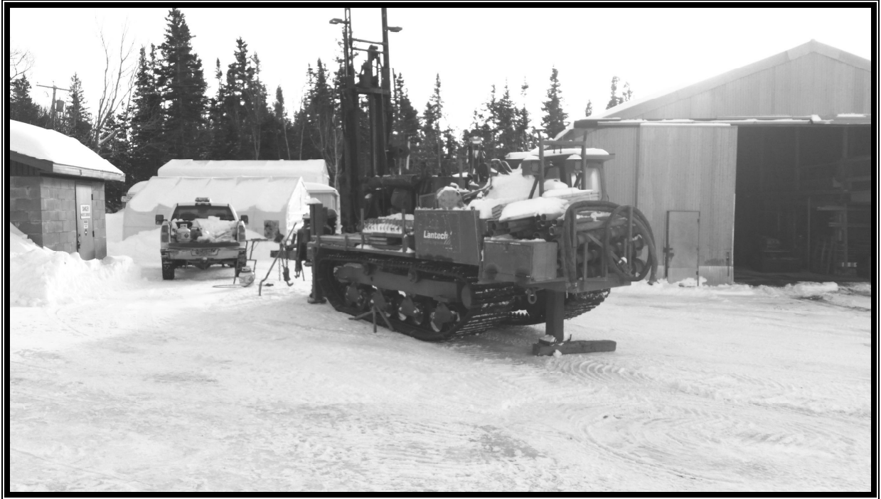
Photo 7 : Secteur du bâtiment non-chauffé (TF-FB12-18)
