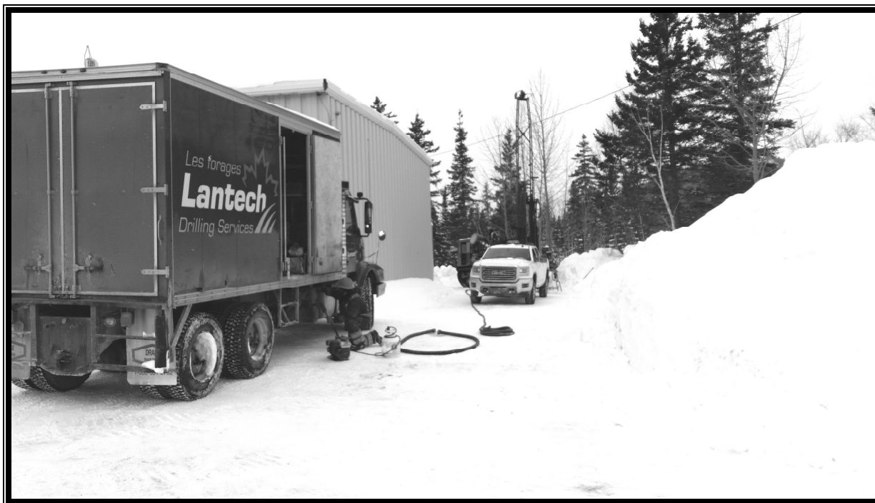
Photo 4 : Secteur du bâtiment administratif projeté (TF-FB02-18)
