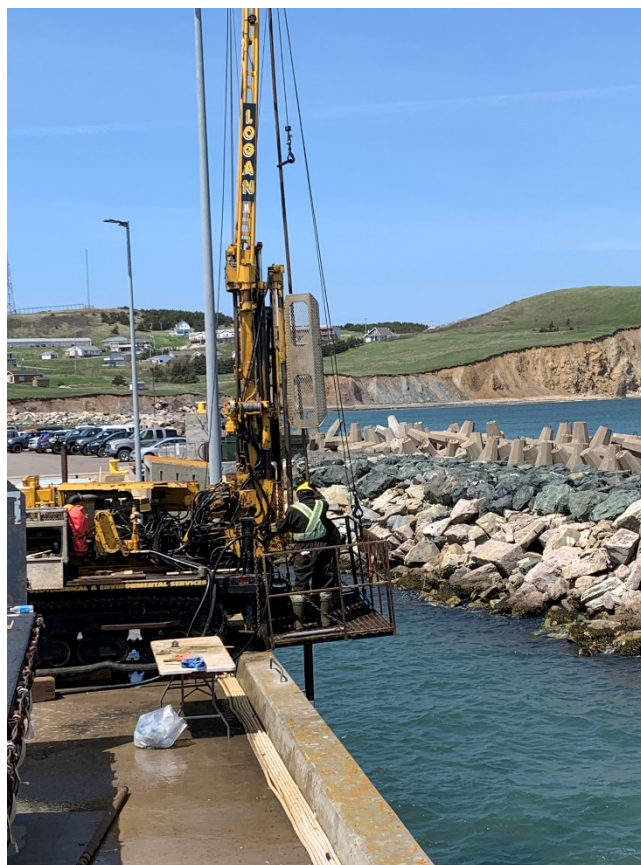
Foreuse sur chenilles avec porte à faux
