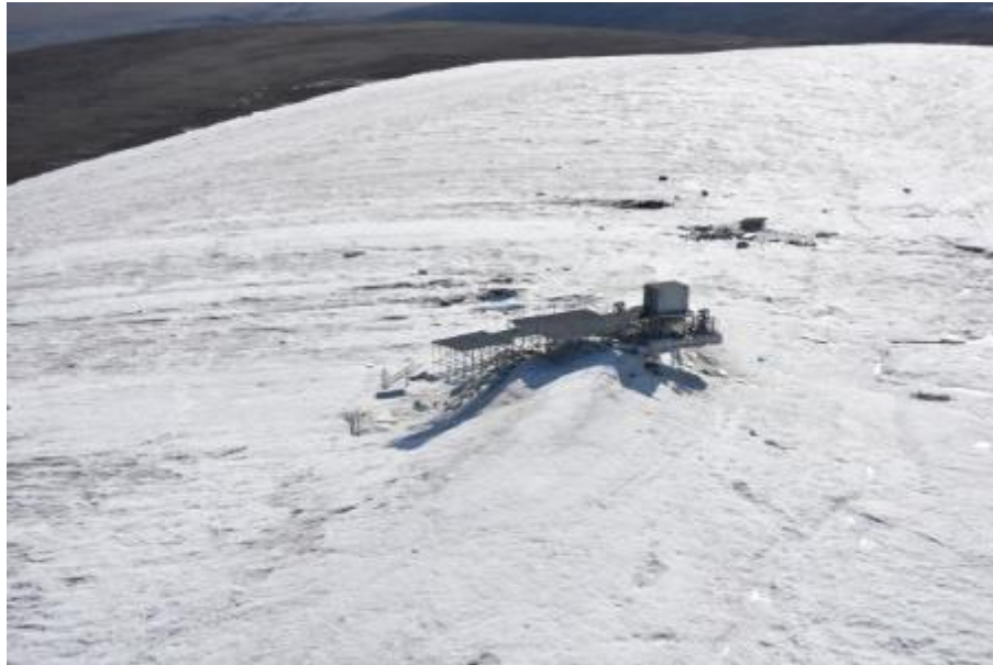
Figure 50 : 24 juillet 2020 – Plateforme du site du mont Arthur (1)
