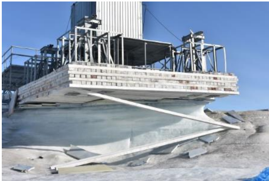
Figure 56 : 24 juillet 2020 – Plateforme du site du mont Arthur (7)
