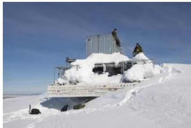
Figure 41 : Partie nord-ouest de la plateforme
