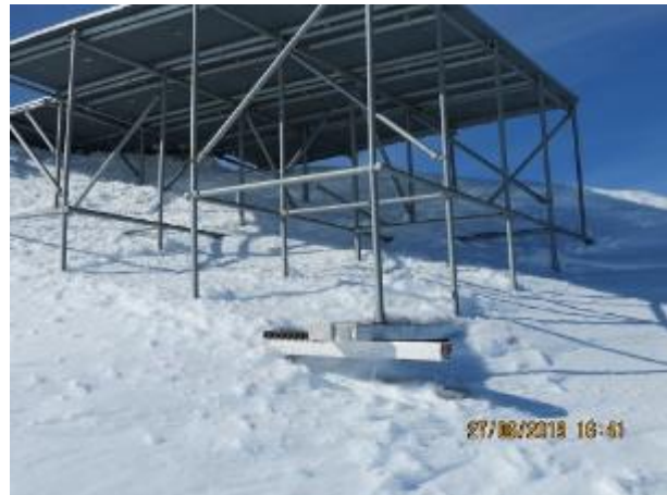
Figure 29 : Gros plan de la partie sud-est de la zone de chargement
