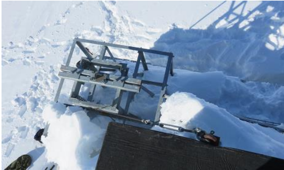
Figure 74 : Caisses de lest de la tour de l'antenne
