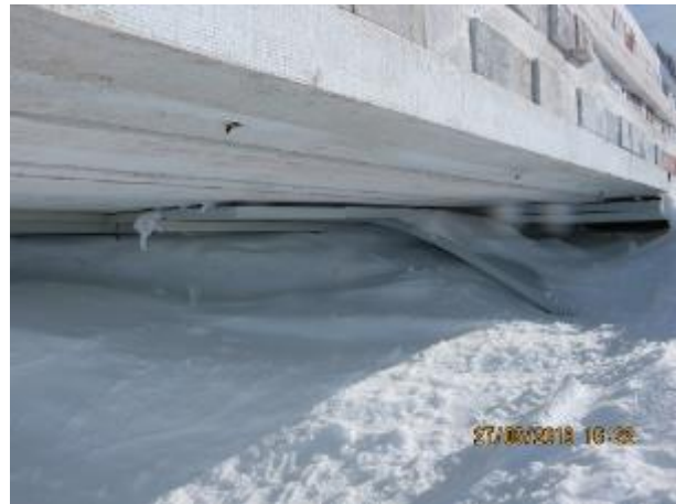
Figure 39 : Vue de deux (2) plaques de polystyrène isolantes (épaisseur totale de 4 po) placées initialement sous la structure de bois pour prévenir les transferts de chaleur vers la surface de glace. Une quantité importante de plaques de polystyrène a disparu et est supposée être ensevelie sous la glace de la montagne.
