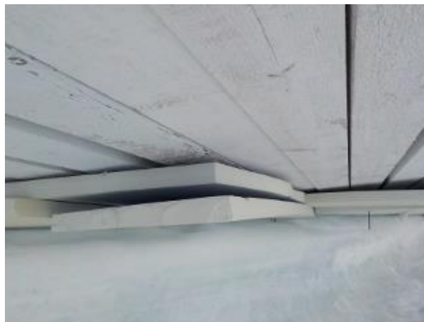
Figure 66 : Isolation en polystyrène
