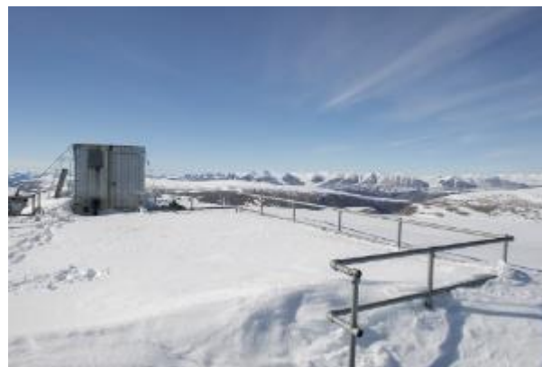
Figure 23 : Vue de l'abri de l'équipement abandonné sur la plateforme
