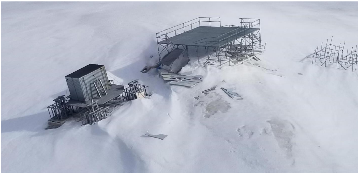
Figure 62B : 4 août 2021 – Bris de la plateforme du site du mont Arthur en trois sections distinctes
