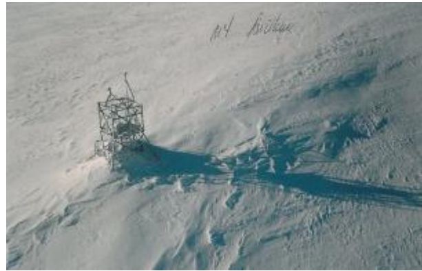
Figure 12 : Site du répéteur de faisceaux hertziens du mont Mont Arthur (1997)
