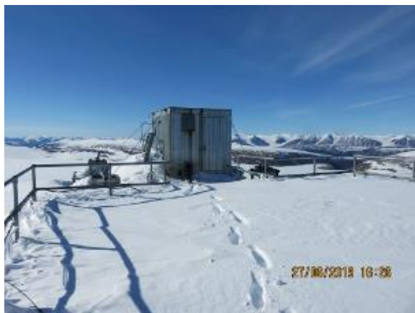
Figure 22 : Vue de l'abri de l'équipement abandonné sur la plateforme
