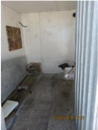
Figure 24 : Vue à l'intérieur de l'abri de l'équipement abandonné
