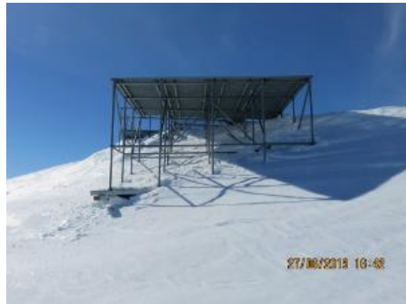
Figure 19 : Vue de la plateforme en direction ouest
