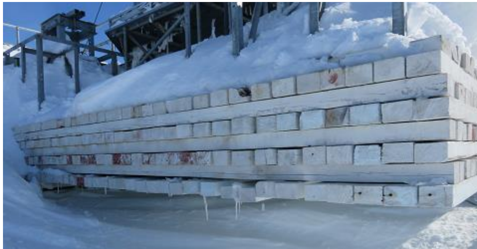
Figure 68 : Couches de poutres de bois soutenant la plateforme Sept (7) couches sous la plateforme complète, plus une couche supplémentaire sous les caisses de lest des tours
