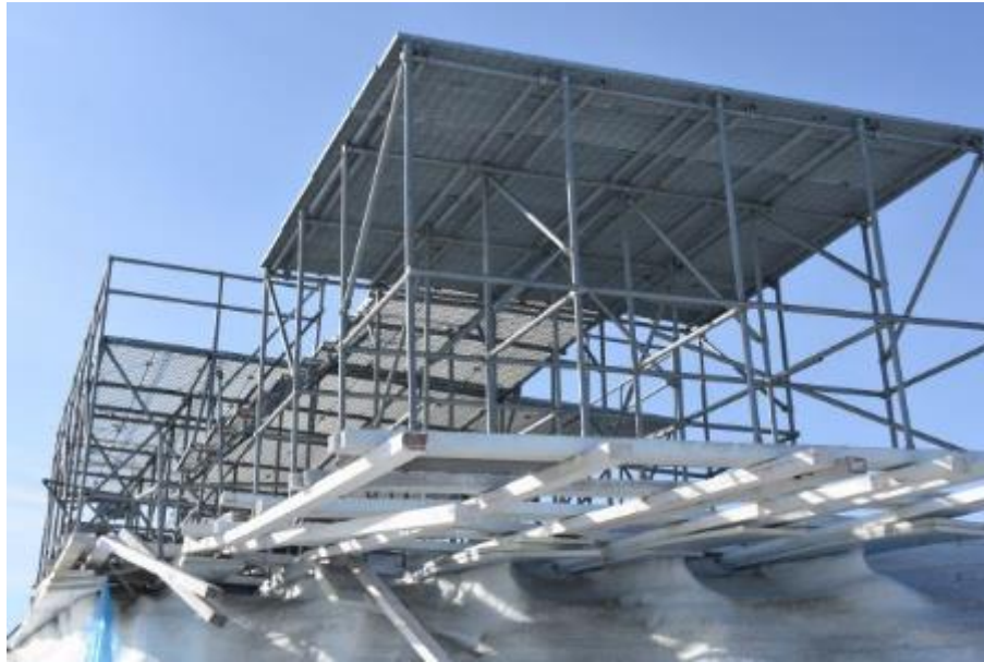
Figure 55 : 24 juillet 2020 – Plateforme du site du mont Arthur (6)
