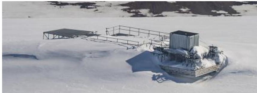
Figure 71 : Garde-corps de sécurité
