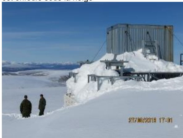
Figure 20 : Vue de la zone de l'abri des équipements sur la plateforme
