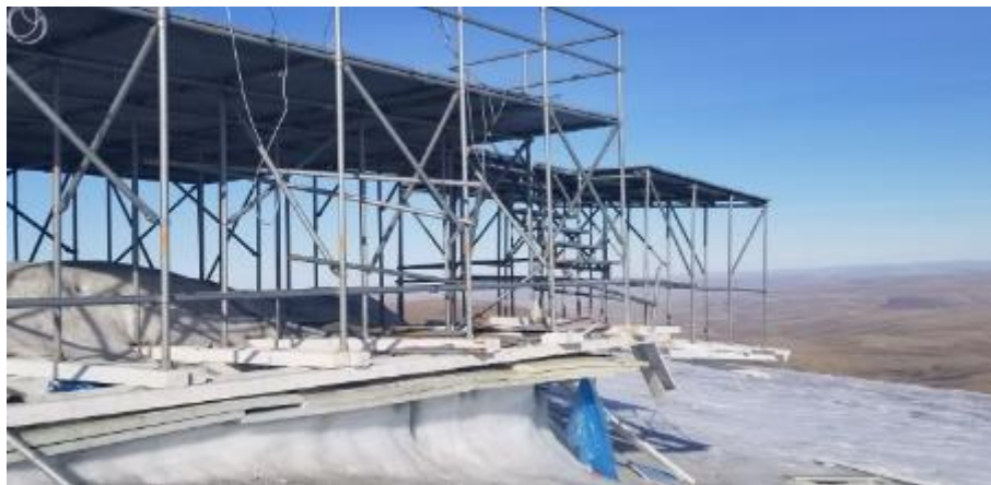
Figure 53 : 24 juillet 2020 – Plateforme du site du mont Arthur (4)
