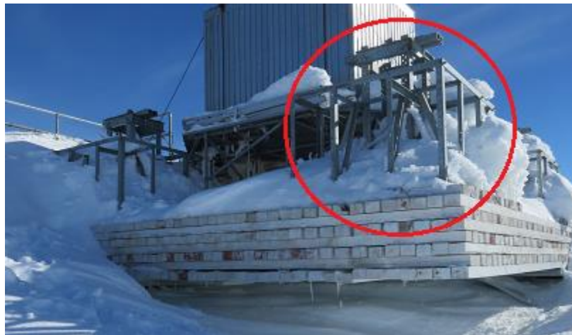
Figure 73 : Caisses de lest de la tour de l'antenne
