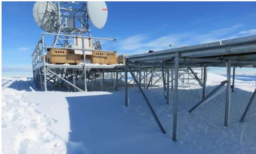
Figure 69 : Plateforme en treillis d'acier (répéteur du site Yankee)
