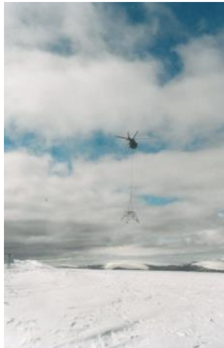
Figure 13 : Mont Arthur – tour d'antenne retirée du site (1997)
