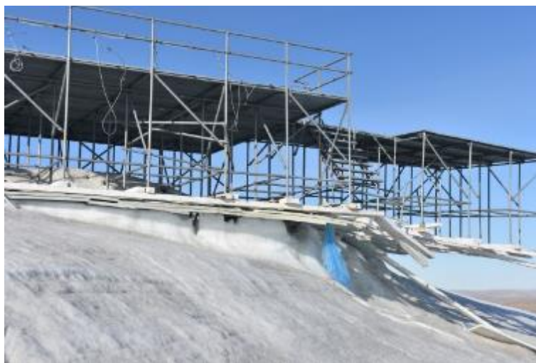
Figure 54 : 24 juillet 2020 – Plateforme du site du mont Arthur (5)
