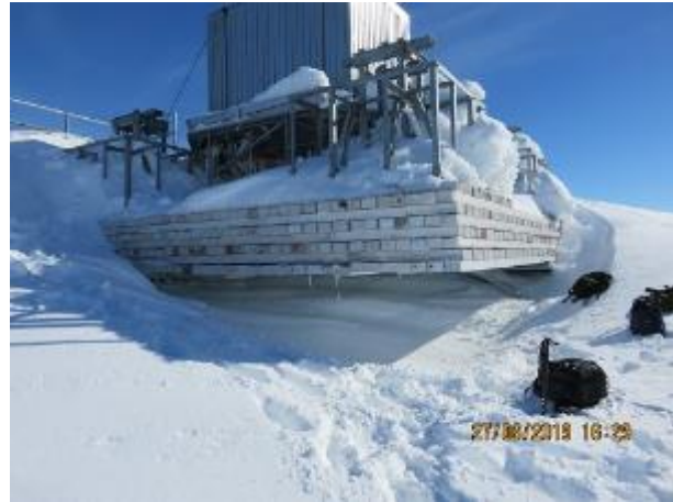
Figure 35 : La partie inférieure de la structure en bois est en train de se séparer.
