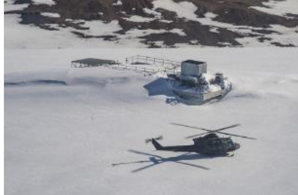
Figure 15 : Site du répéteur de faisceaux hertziens du mont Arthur vu du deuxième hélicoptère
