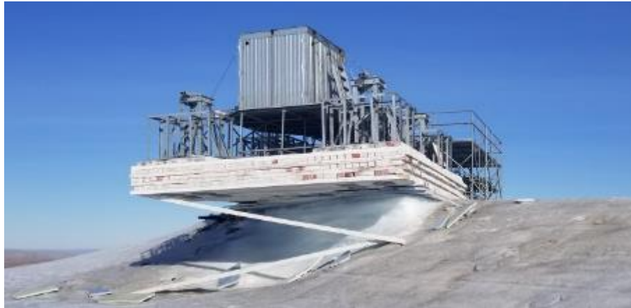
Figure 52 : 24 juillet 2020 – Plateforme du site du mont Arthur (3)
