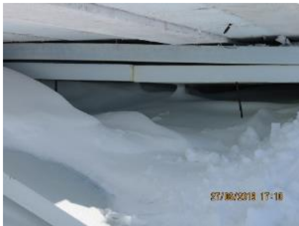
Figure 40 : Les couches de polystyrène étaient fixées à la couche de glace par des pieux de 8 po.
