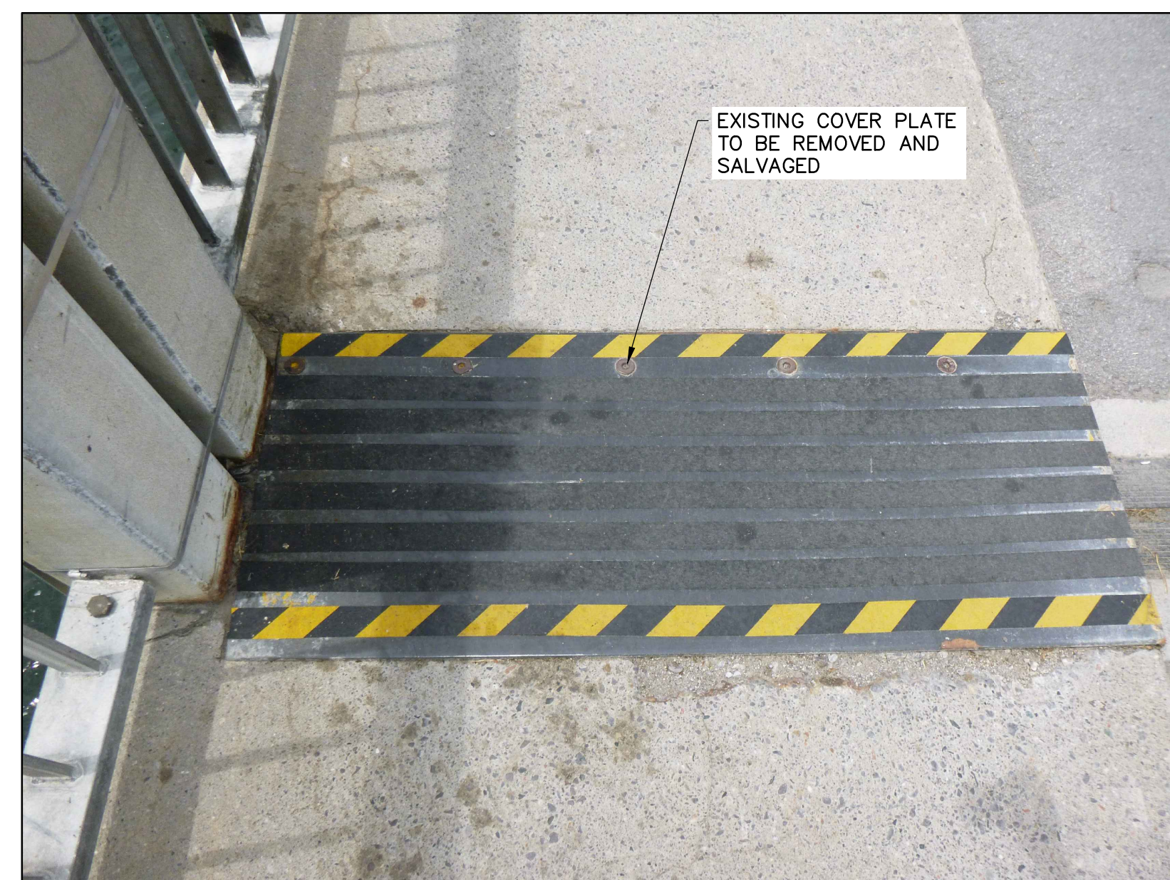
EXPANSION JOINT N.T.S.
