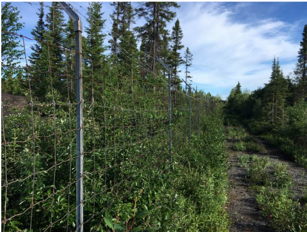
Photo 24 – Loose barb wire and mesh (Sta. 0+200).
