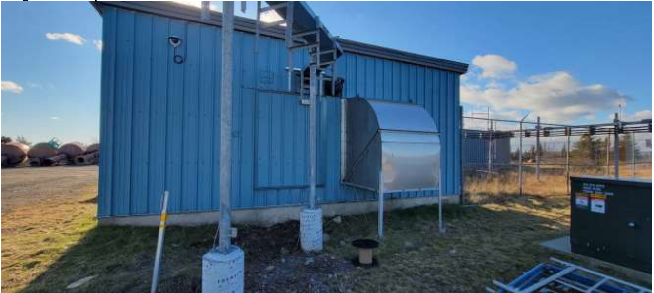
Photo 1: Entrée du bâtiment
