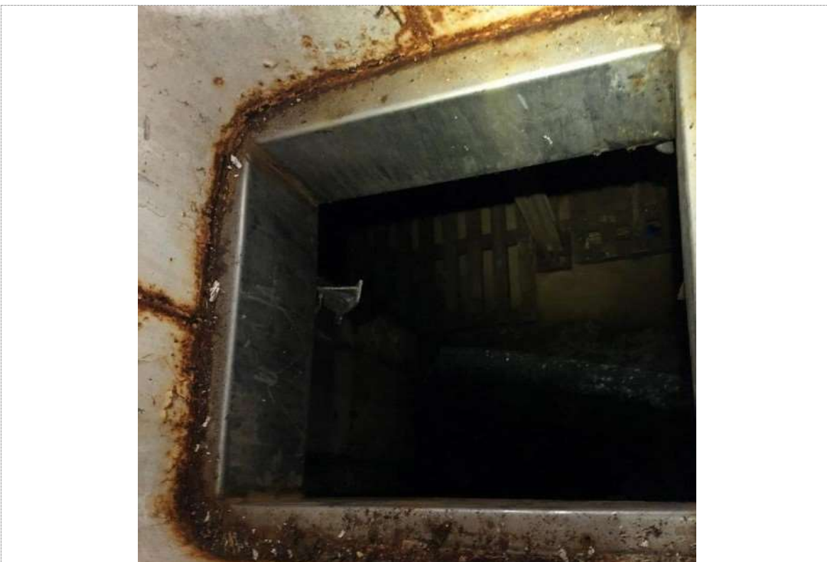
20. Pont de traitement - vue de l'espace de chargement à travers
