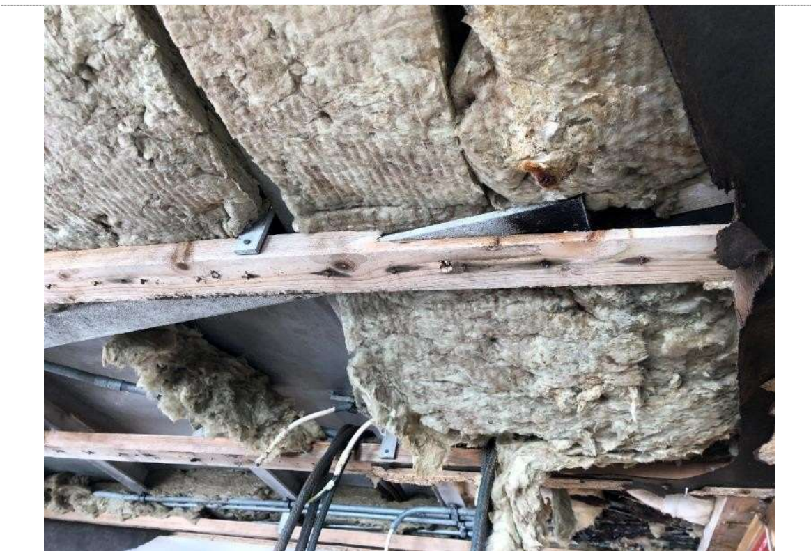
4. Pont – vue du plafond
