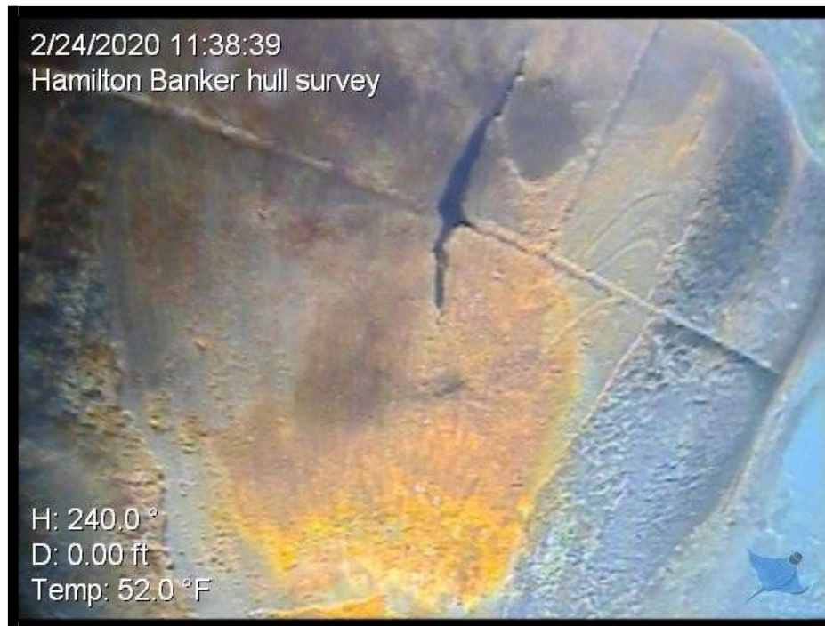
Figure 12 - La zone endommagée montre une fissure dans la coque, à l'arrière à bâbord.
