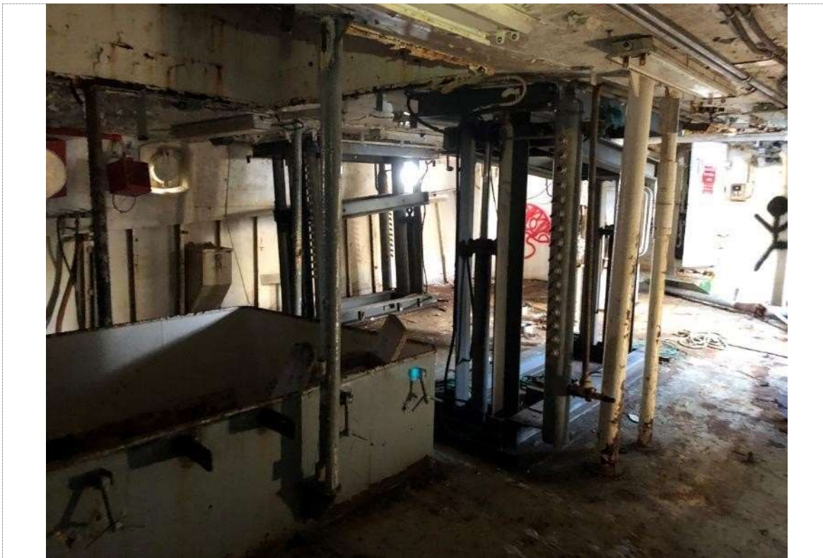
17. Pont de traitement (2)
