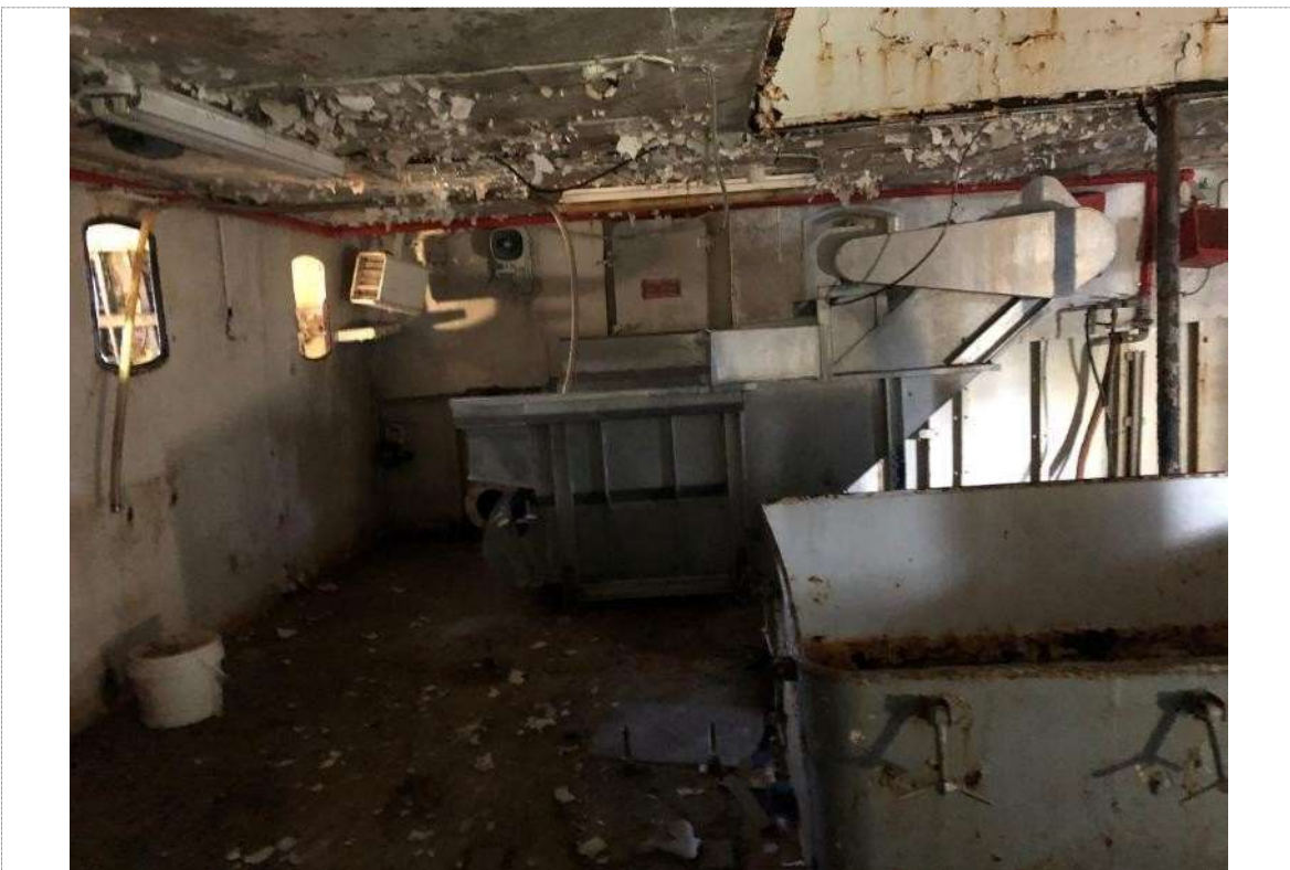
16. Pont de traitement (1)
