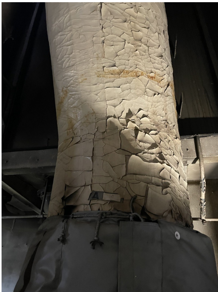
Figure 1: Isolation conduit d'échappement moteur
