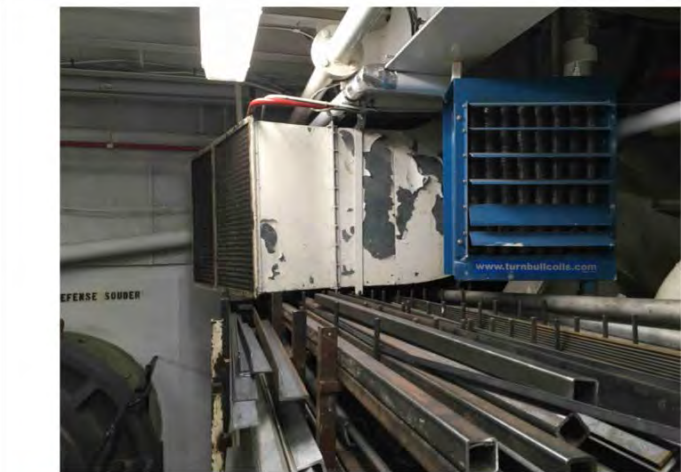
13 Peinture (Pb+Hg) Propulsion — N/A — Beige — Élément mécanique — N/A — Écaillé Chantal.Soulard - 2021-03-25 10:54
