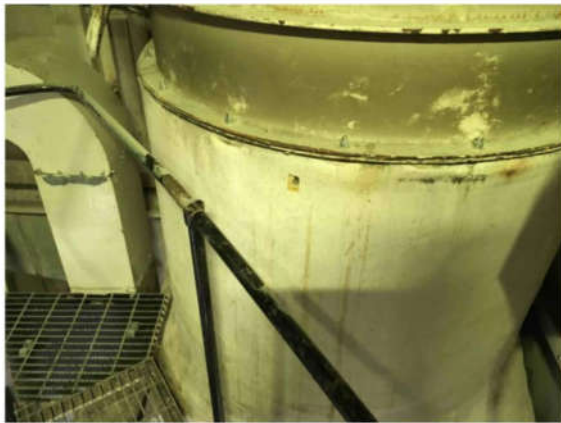
4 Amiante échantillon Pont supérieur — Cheminée Audrey.Corbeil - 2021-12-14 12:51 Canevas sur ventilation salle des machines (alimentation) échantillon 4a
