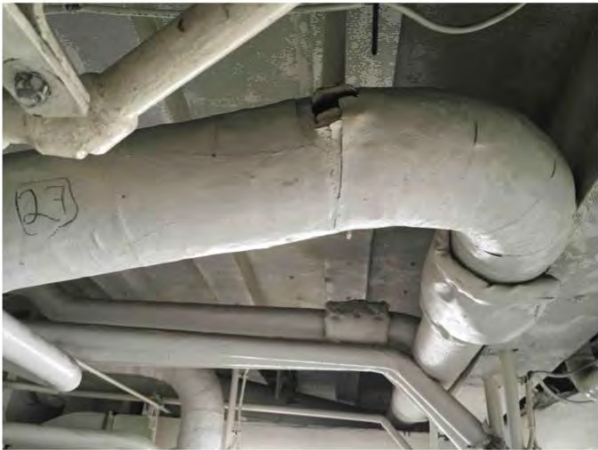
1 Amiante Plate-Forme 17'-0" — N/A — Tuyauterie — N/A — Pâte cimentaire — Passable — N/A Chantal.Soulard - 2021-03-25 11:11 À recouvrir
