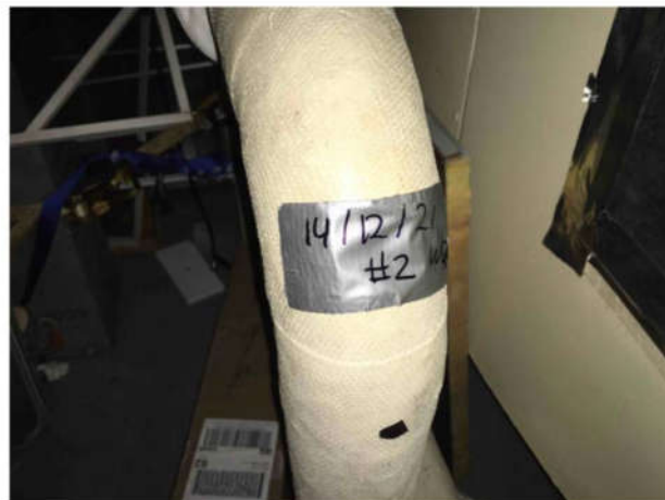
2 Amiante échantillon Pont de navigation — Crawl space Audrey.Corbail - 2021-12-14 11:54
