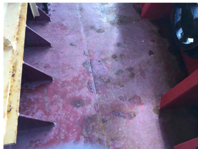
9 Peinture (Pb+Hg) Pont supérieur — N/A — Rouge — Plancher — N/A — Écaillé Chantal.Soulard - 2021-03-25 15:48
