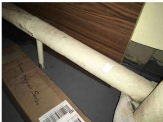
3 Amiante échantillon Pont de navigation — Crawl space Audrey.Corbail - 2021-12-14 11:57 Échantillon 3a (unité de chauffage timonerie : retour vapeur). Canevas et pâte cimentaire de l'unité de chauffage timonerie
