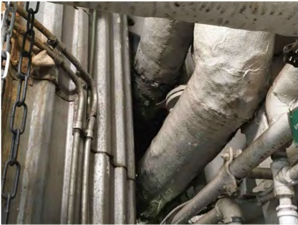
2 Amiante Plate-Forme 17'-0" — N/A — Tuyauterie — N/A — Pâte cimentaire — Passable — N/A Chantal.Soulard - 2021-03-25 11:13
