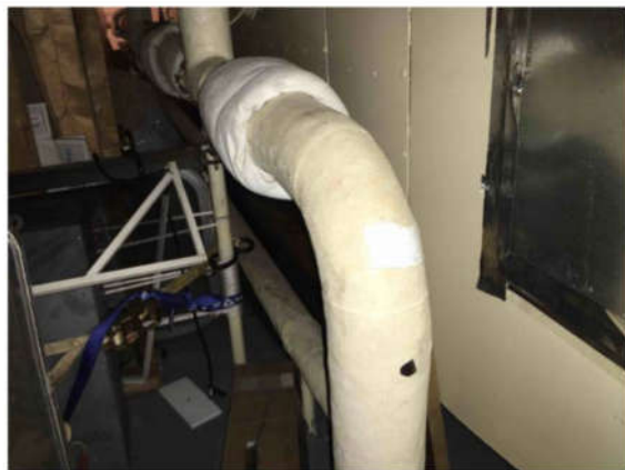
2 Amiante échantillon Pont de navigation — Crawl space Audrey.Corbail - 2021-12-14 11:53 Canevas et pâte cimentaire de l'unité de chauffage timonerie (alimentation vapeur).
