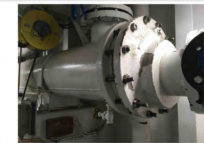
16 Peinture (Pb+Hg) Salle des moteurs — N/A — Blanc — Tuyauterie — N/A — Écaillé Chantal.Soulard - 2021-03-25 11:00
