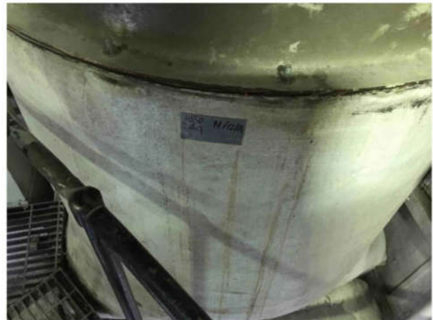
4 Amiante échantillon Pont supérieur — Cheminée Audrey.Corbeil - 2021-12-14 12:52
