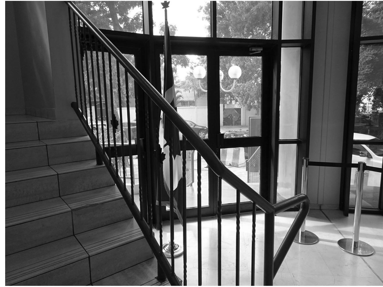
IMAGE DE RÉFÉRENCE POUR DÉMOLITION : MAIN COURANTE À ENLEVER
