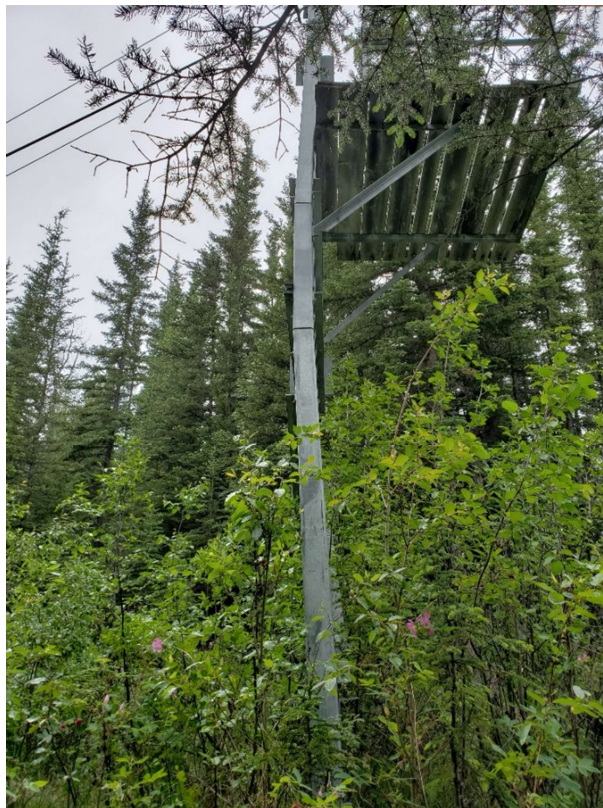
Figure 3 : Cadre en A plié sur la rive droite
