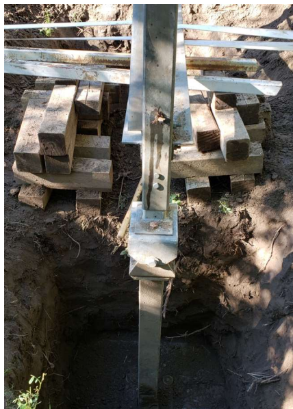
Figure 6 : Installation de plaques de base supplémentaires sous les semelles du cadre en A
