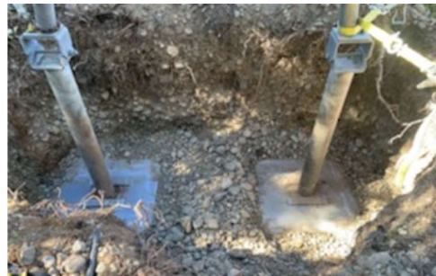
Figure 6 : Installation de plaques de base supplémentaires sous les semelles du cadre en A
