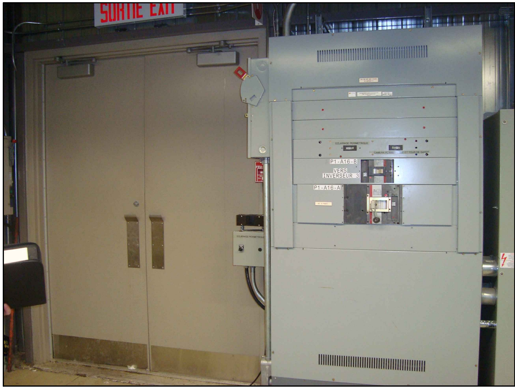
PHOTO PAN. 1200amp. 600V 3 PHASES VIA INVERSEUR PHOTO PAN. 1200amp. 600V 3 PHASES VIA INVERSEUR
