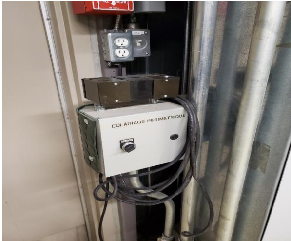
Photographie 3 Vue de la commande de transfert automatique de l'éclairage périmétrique
