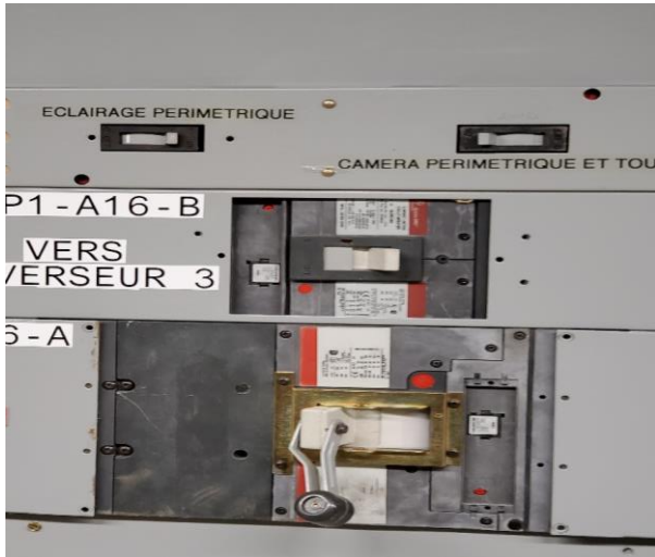
Photographie 4 Vue du disjoncteur – BAT A16 – Éclairage périmétrique 60 A
