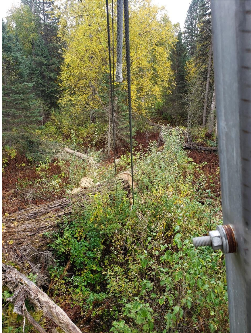
Figure 1 : Arbre tombé à l'emplacement de l'ancrage sur la rive droite
