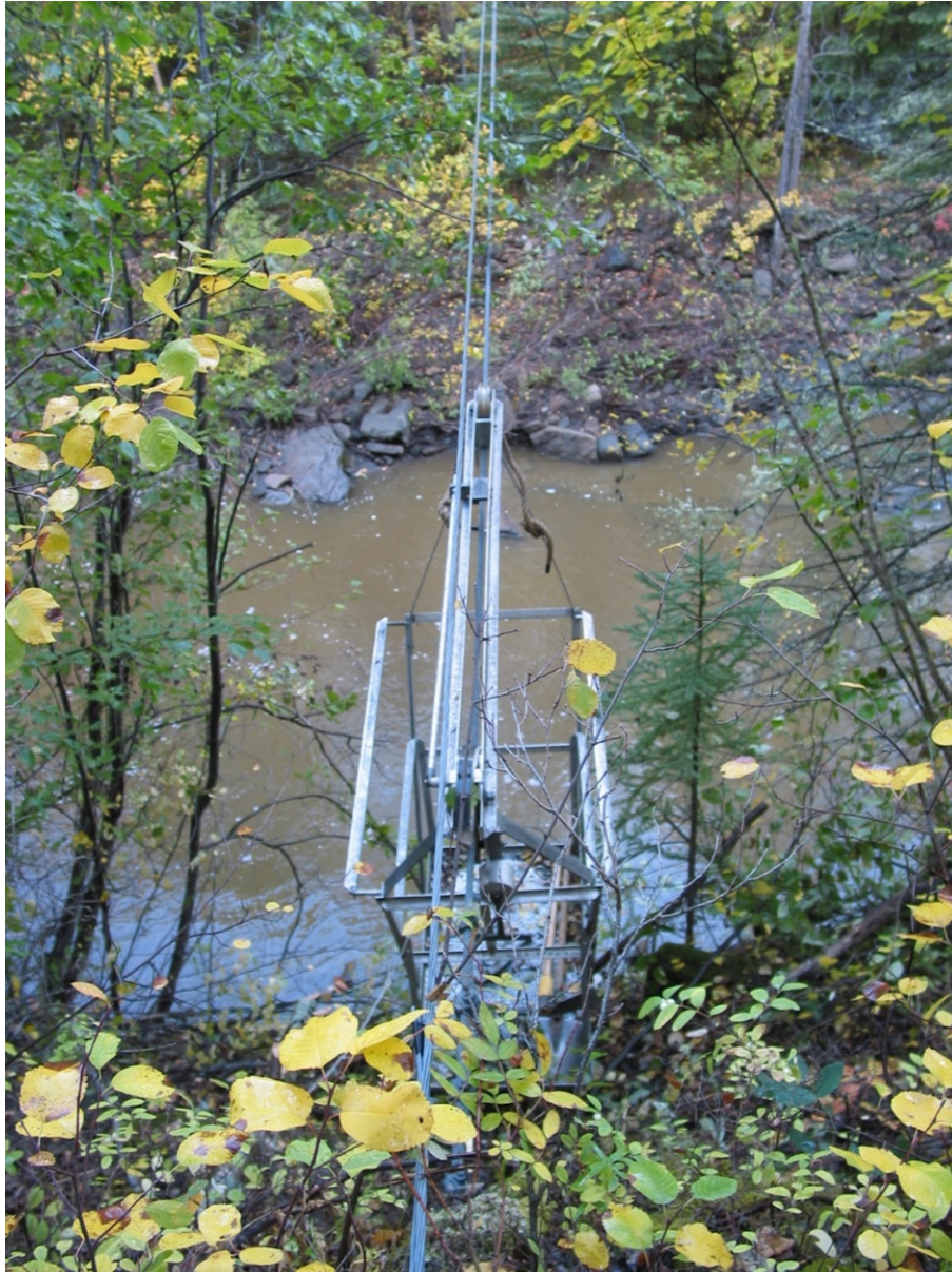
Photo 1. Vue du câble et du bac à câble depuis la rive droite (côté éloigné)
