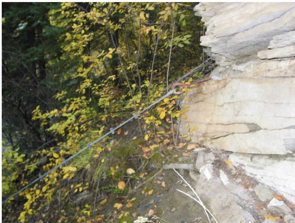
Photo 5. Ancrage du câble de signalisation (rive droite, côté éloigné)
