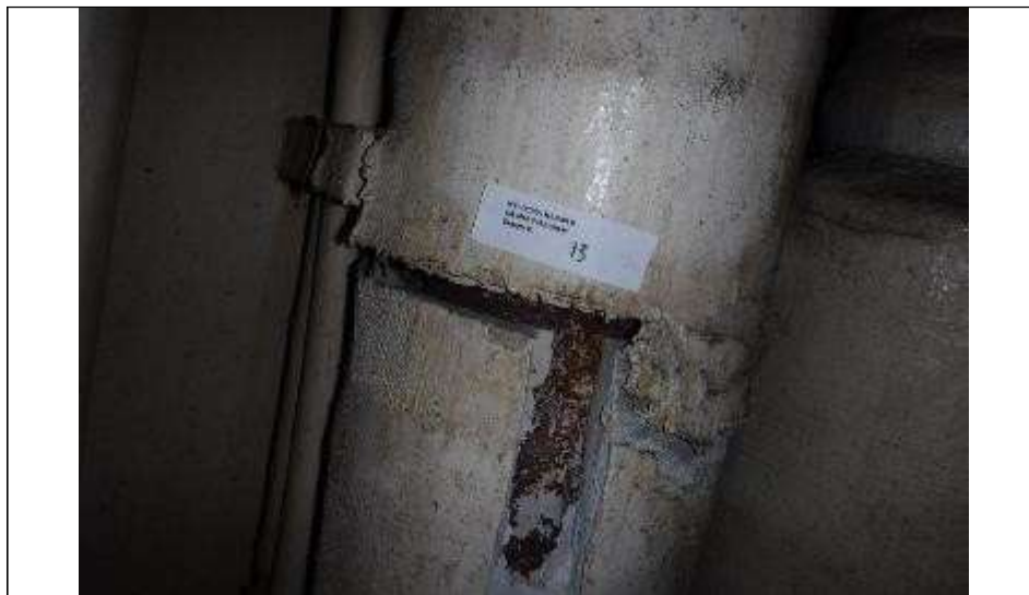
12. Isolant d'une canalisation d'échappement des moteurs principal et auxiliaire. Les échantillons 13 et 14 contenaient de l'amiante.
