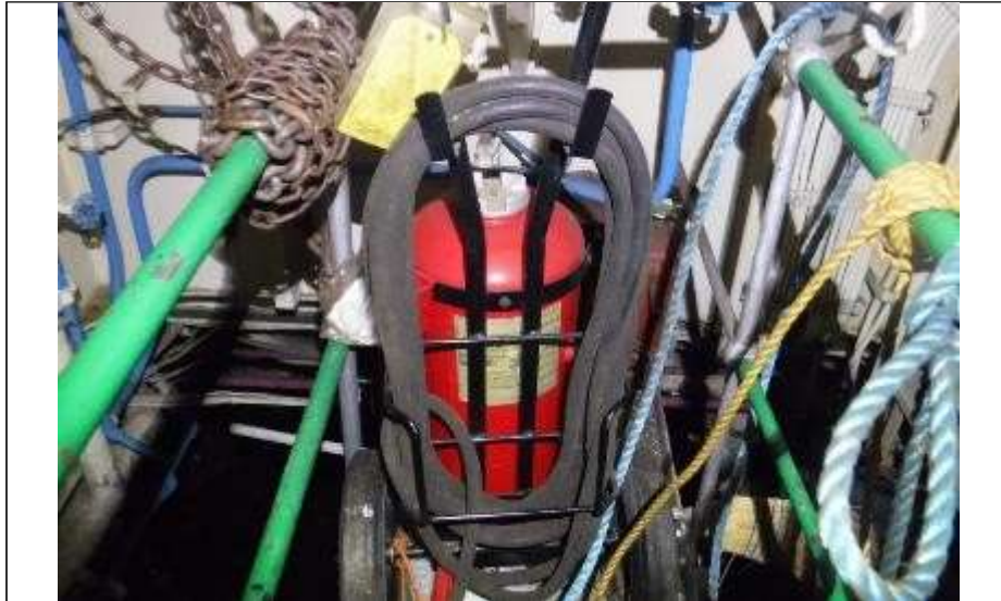
13. Extincteurs d'incendie au CO 2 , à l'eau et à poudre chimique.
