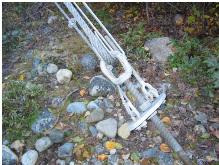
Photo 3. Points d'ancrage de la rive droite (rive éloignée)
