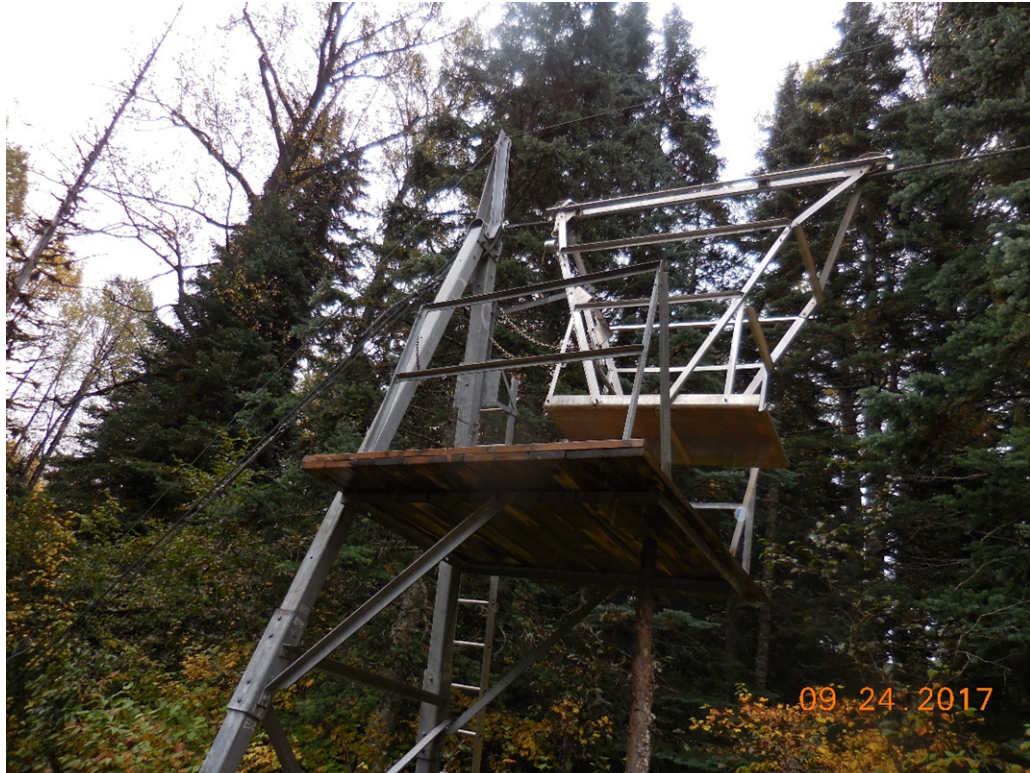
Photo 2. Bac à câble existant
