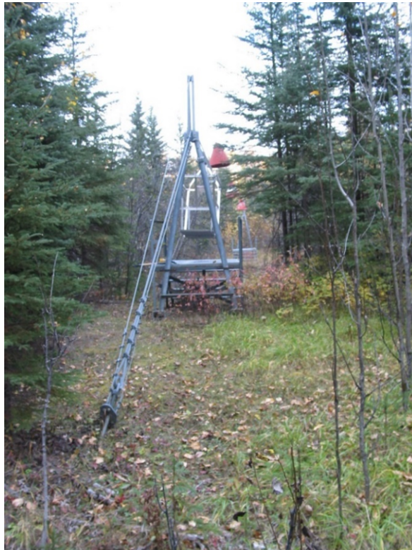
Photo 4. Cadre en A et plateforme du côté arrivé
