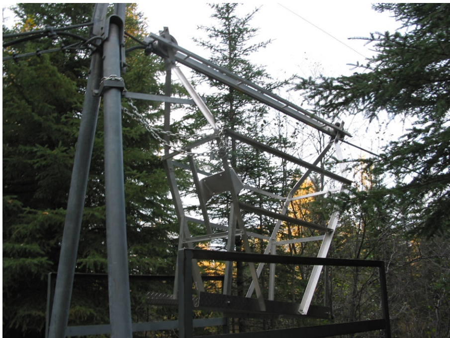
Photo 2. Bac à câble existant
