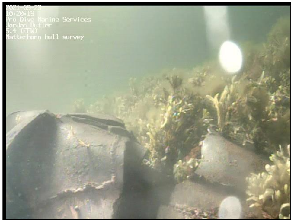
Figure 4 – Dommages à la proue au-dessus de la ligne de flottaison
