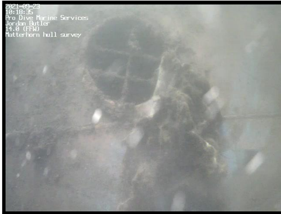
Figure 19 – Propulseur d'étrave avant
