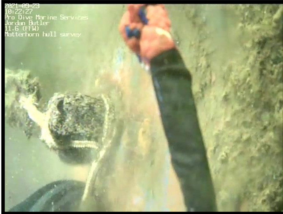
Figure 7 – Bouchon installé derrière la zone de proue sous la ligne de flottaison.
