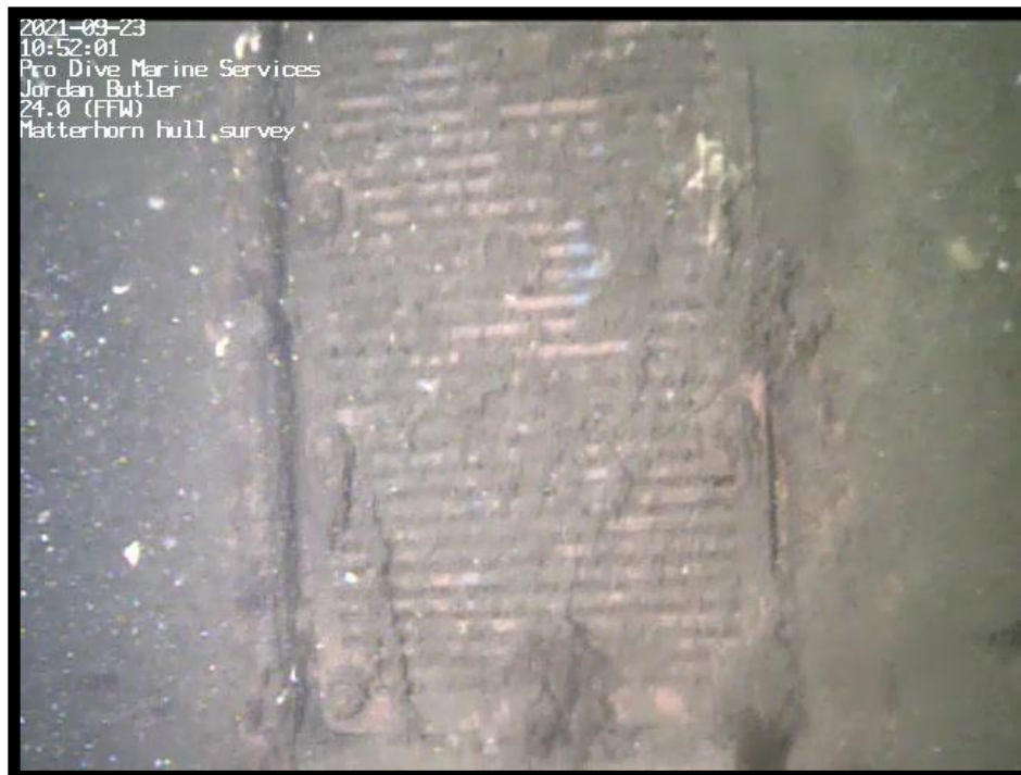
Figure 18 – État du caisson de prise d'eau.
