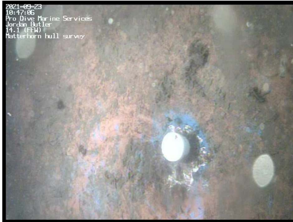
Figure 17 – Bouchon installé du cote tribord
