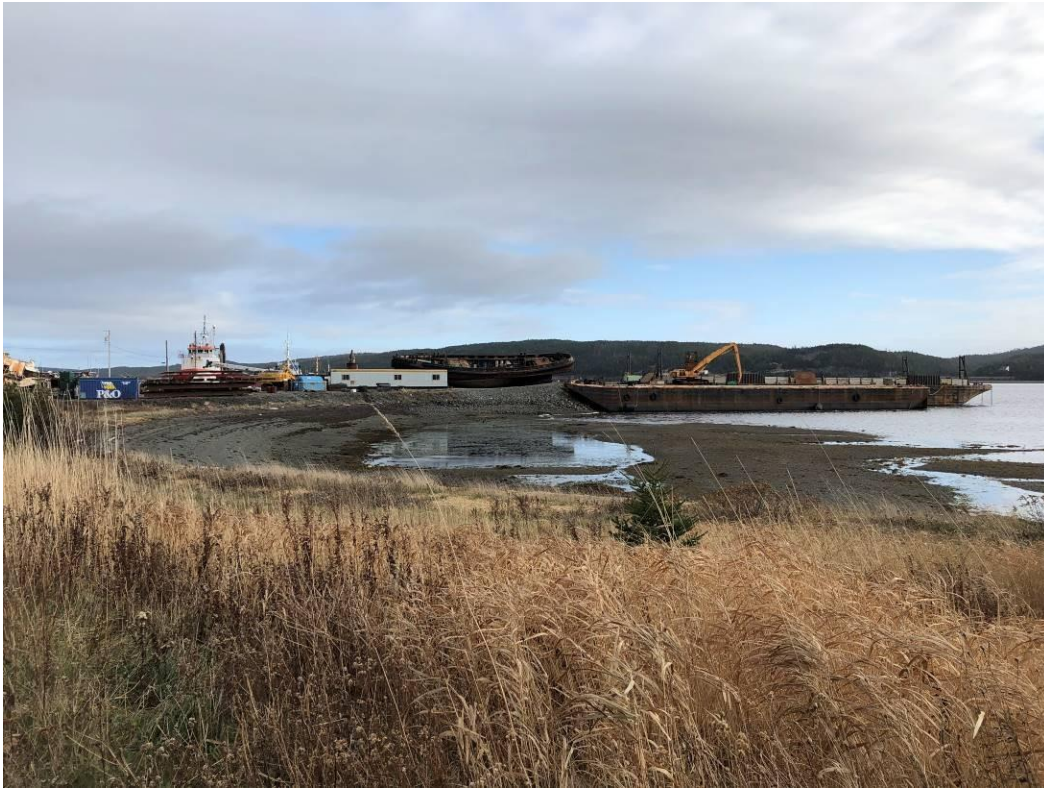
3. Vue de l'installation vers le nord. MATTERHORN coulé au-delà des deux barges
