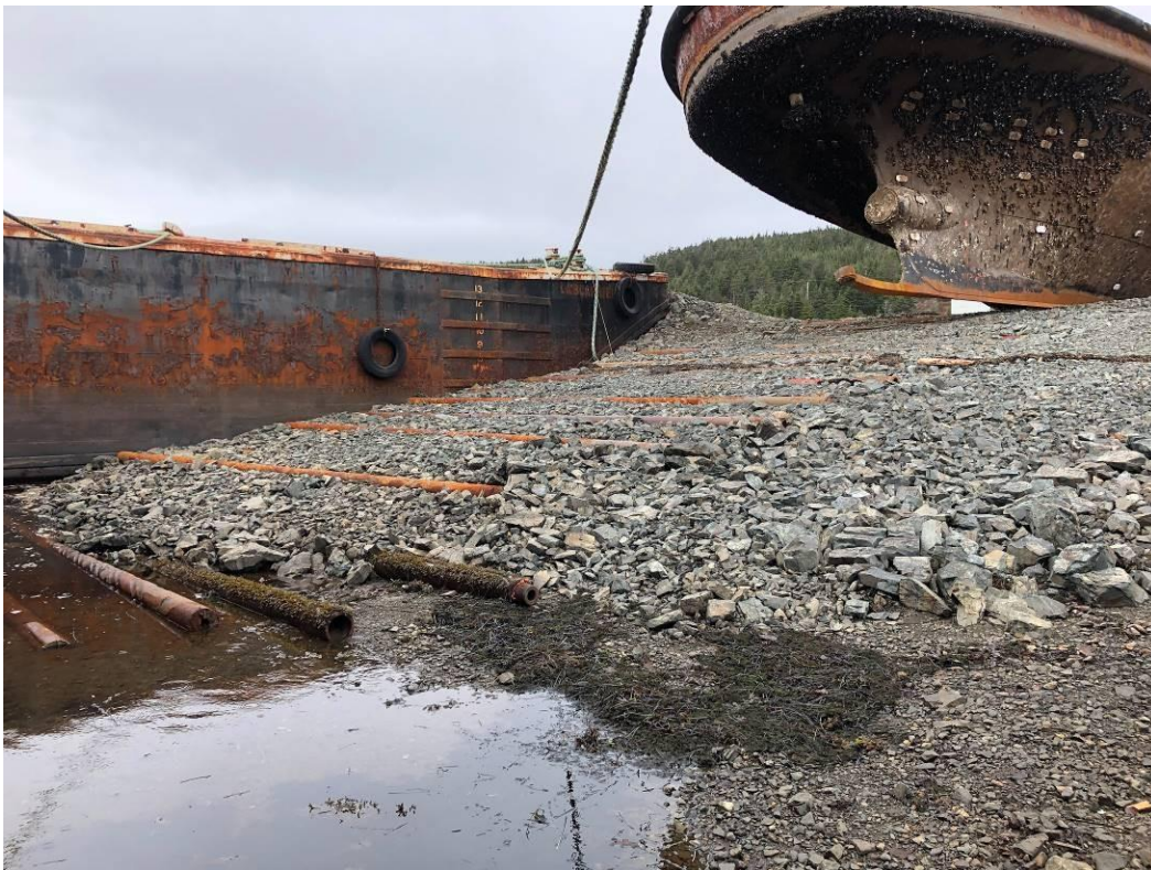
6. « Cale de halage » utilisant des tiges de forage comme patins
