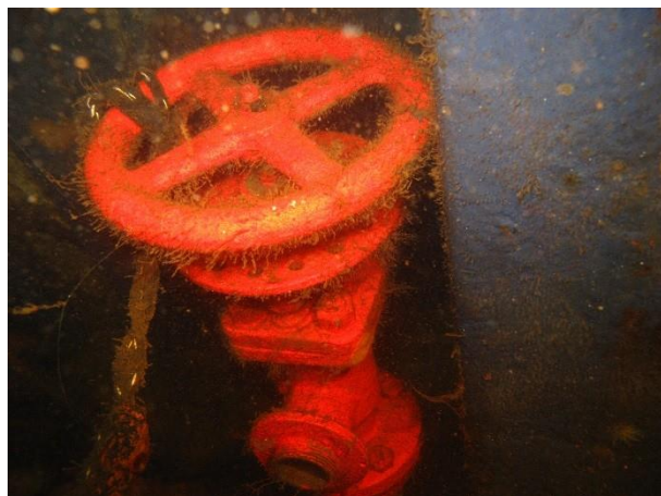
Montre le robinet-vanne en position fermée.
