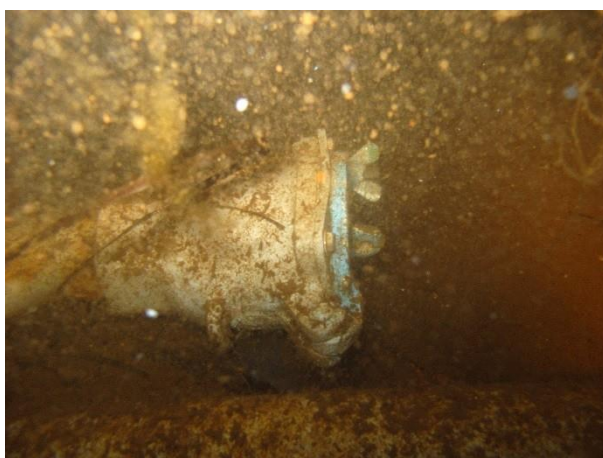
Montre la pénétration sécurisée avec un capuchon d'extrémité. Montre l'évent sécurisé avec une plaque d'acier.
