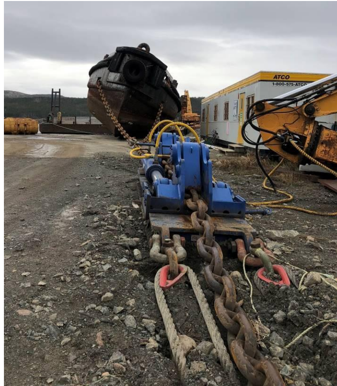
9. Restes du remorqueur ex NORTHERN TUGGER relié à l'extracteur à chaîne
