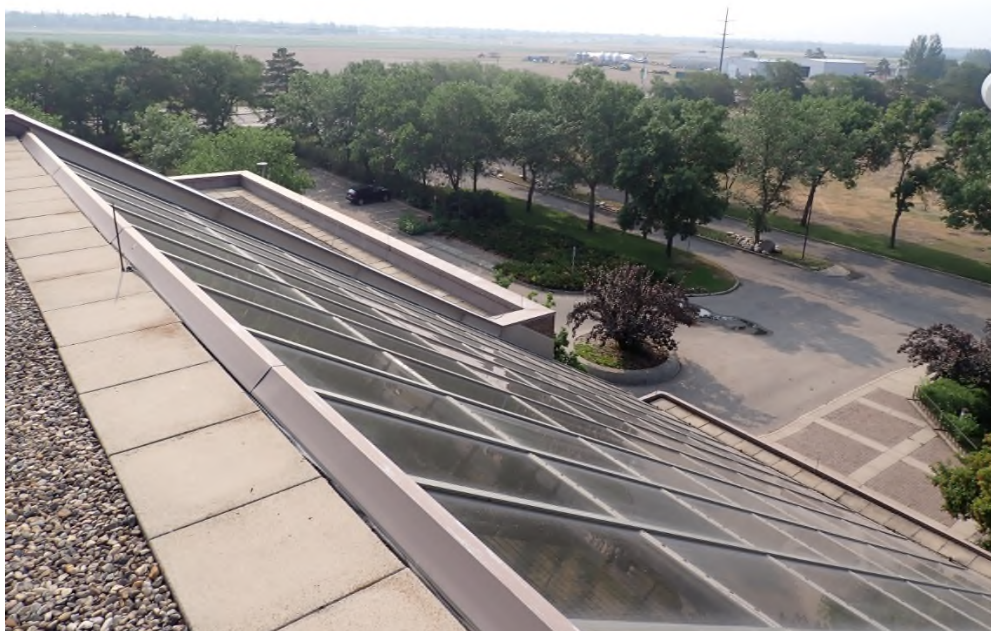
Photo 4 – Aperçu de la transition supérieure du toit vers le vitrage en pente.
