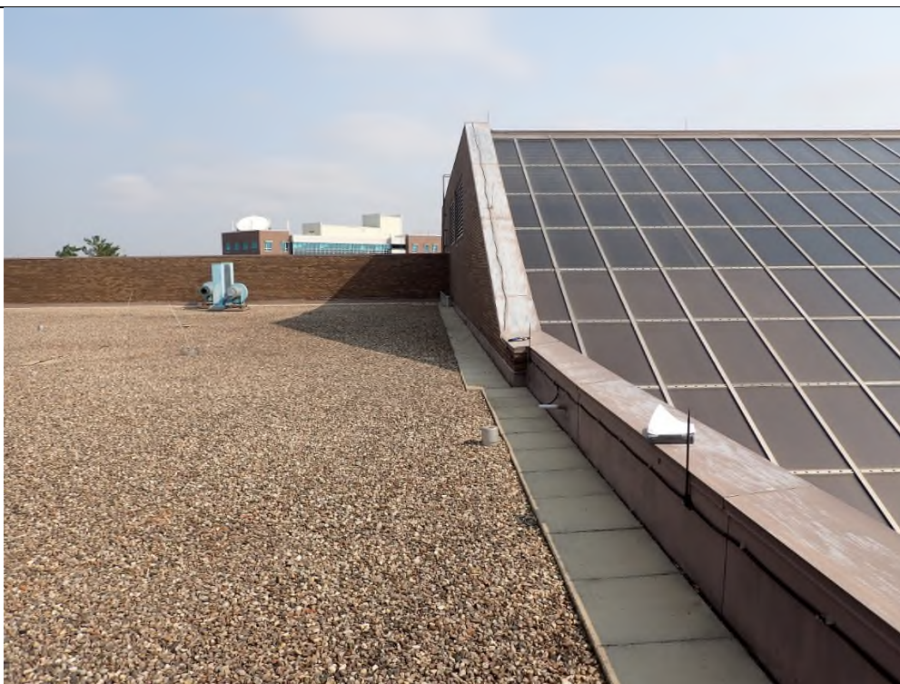
Photo 3 Aperçu de la transition du vitrage en pente vers le mur du bâtiment existant.
