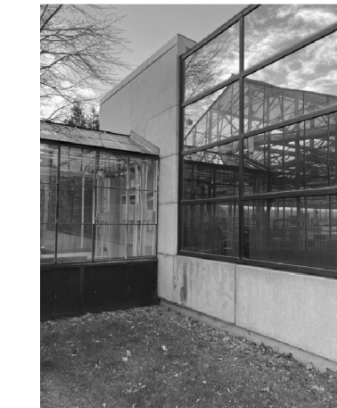
FAÇADE NORD OUEST - SECTEUR 3 NORTH WEST FACADE - SECTOR 3
