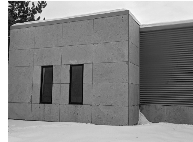
FAÇADE NORD OUEST - SECTEUR 3 NORTH WEST FACADE - SECTOR 3
