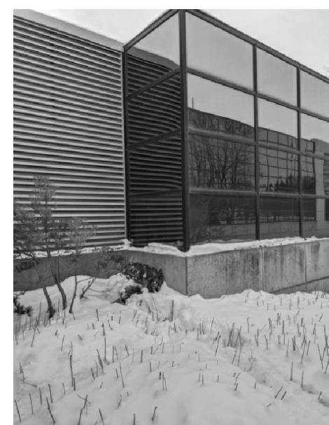
FAÇADE NORD OUEST - SECTEUR 3 NORTH WEST FACADE - SECTOR 3
