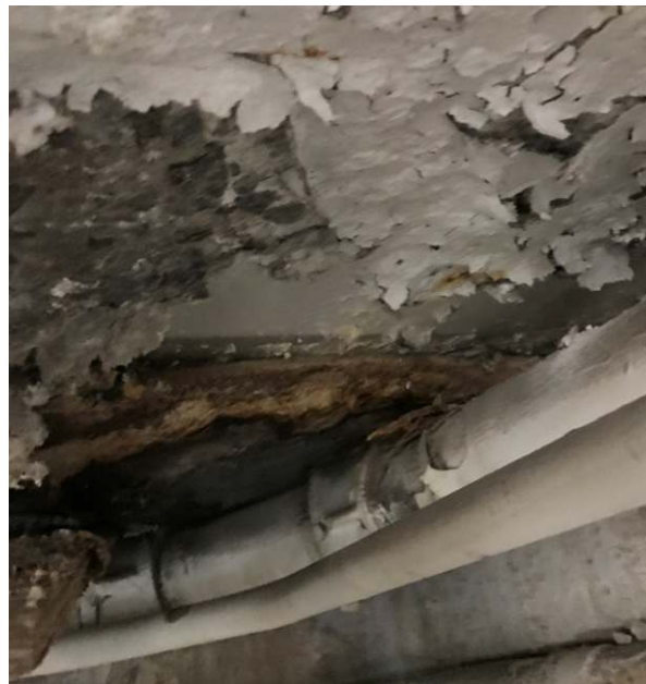
Photo 8. De la peinture de plafond blanche, à l'intérieur du tunnel et en dessous de l'évent V1 et de Type D; ici, l'on confirma que cette peinture renfermait 918 ppm de plomb (Échantillon de la société DST, portant l'identification : 3603-LP01).
