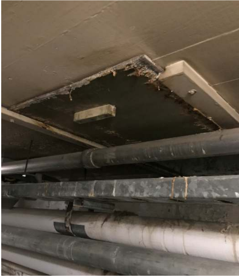
Photo 9. Peinture de plafond grise, à l'intérieur du tunnel et plus précisément, en dessous de l'évent V2 et de type D; l'on confirma ici qu'il y avait une concentration de 149 ppm de plomb) (Échantillon de la société DST, portant l'identification : 3603-LP02).
