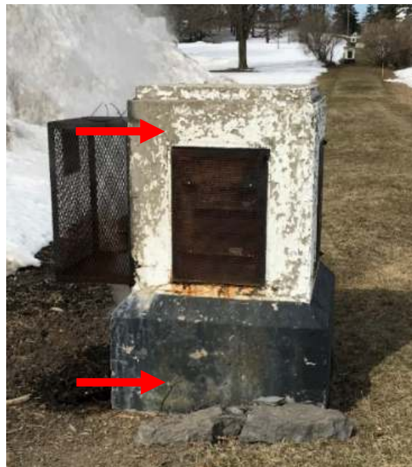
Photo 4. Peinture blanche, associée à des évents de Type M; ici, l'on confirma que cette peinture renfermait 5 710 ppm de plomb (Échantillon de la société DST, portant l'identification : 1154-LP18). Peinture noire, associée à des évents de type M; ici, l'on confirma que cette peinture renfermait 294 ppm de plomb (Échantillon de la société DST, portant l'identification : 1154-LP19).
