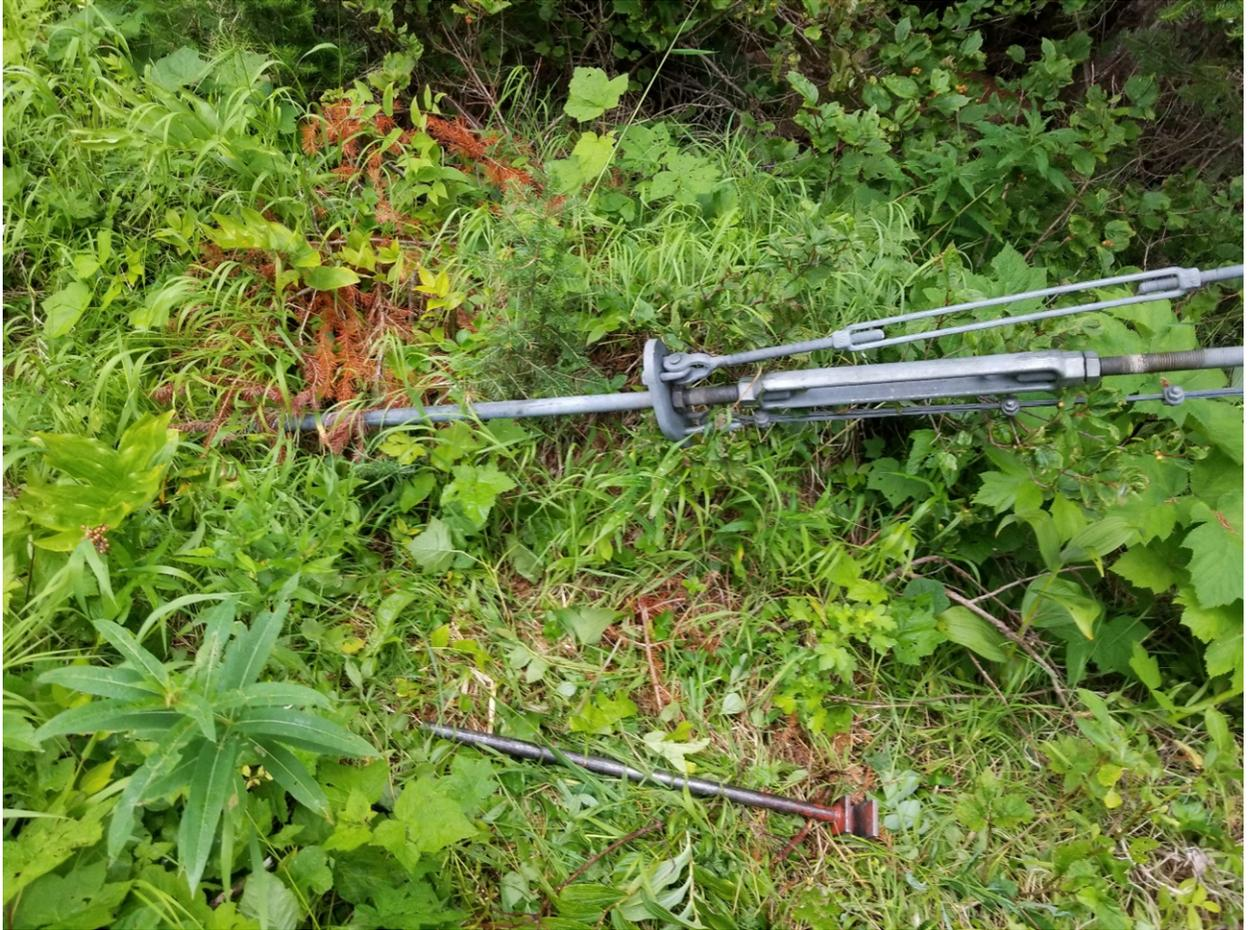
*Photo 7: Rive gauche (rive rapprochée) connexion d'ancrage*
