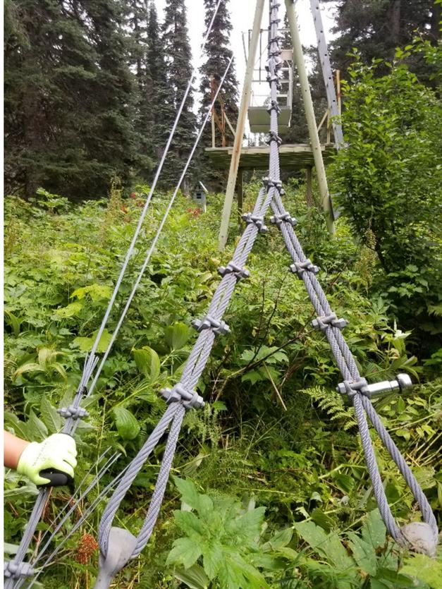
*Photo 2: Rive droite (rive éloignée) câble à patte d'oie*
