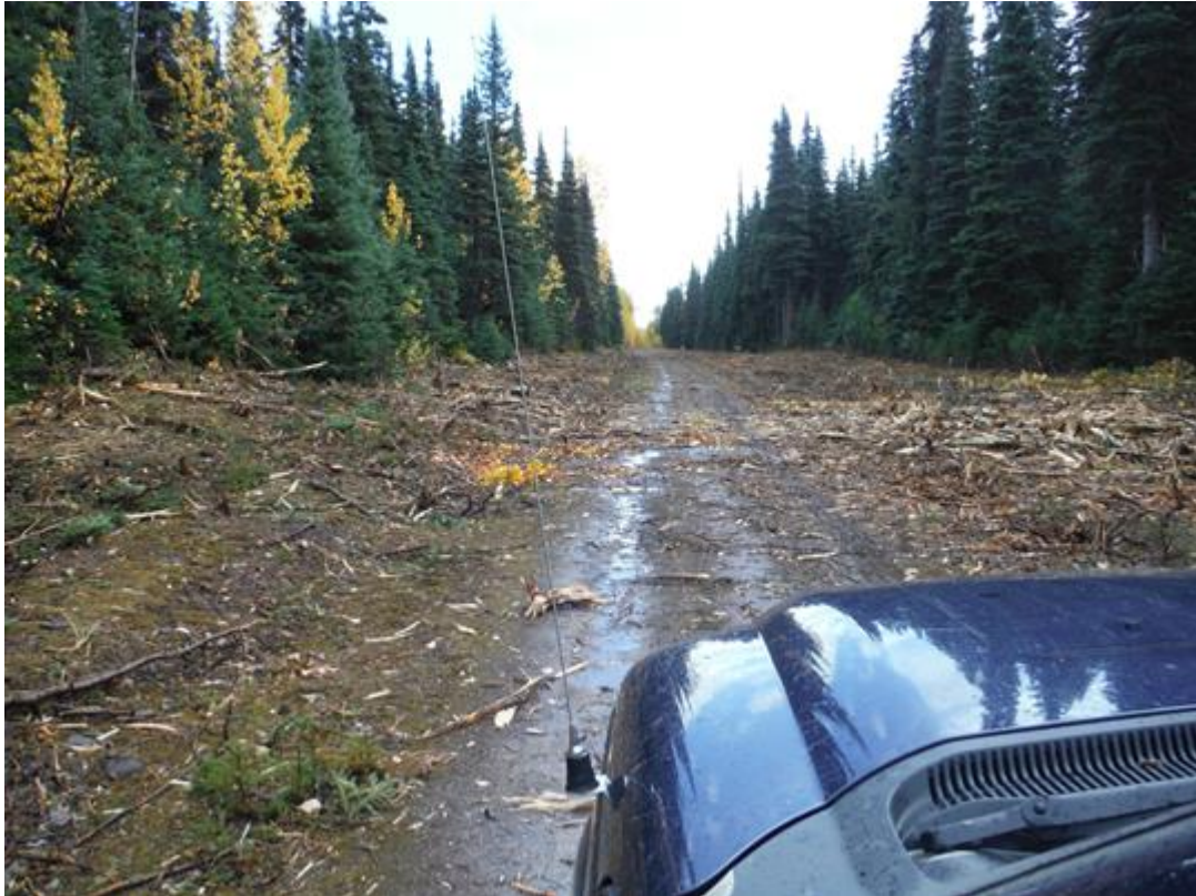
24 septembre 2015 - Route d'accès le long de l'emprise du pipeline ; route encore en bon état en été 2022.
