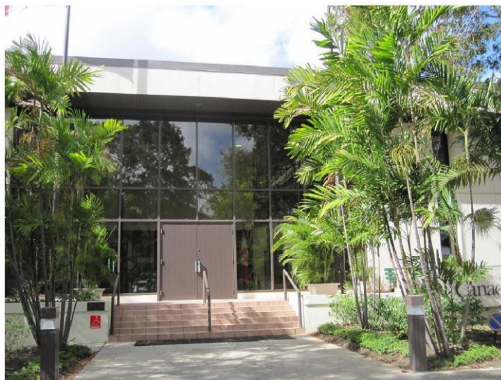
Photographie n° 8 : Façade extérieure
