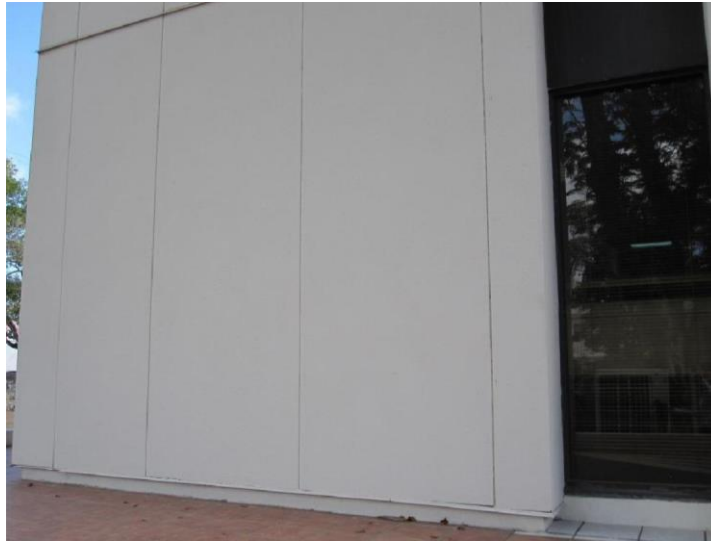
Photographie n° 9 : Façade extérieure
