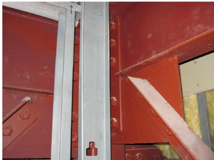
Photographie n° 6 : Poteau et assemblage en acier de construction
