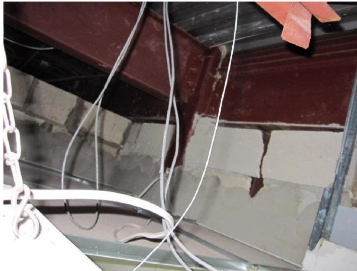
Photographie n° 7 : Cloison de séparation en maçonnerie de béton non renforcée
