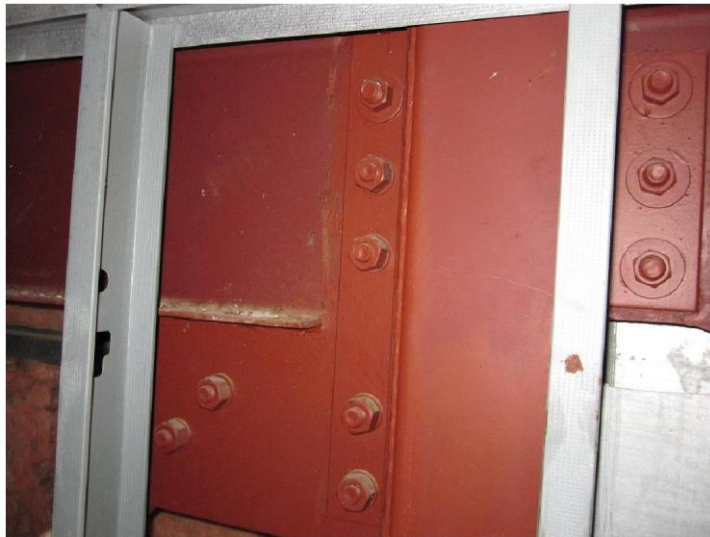
Photographie n° 5 : Poteau et assemblage en acier de construction
