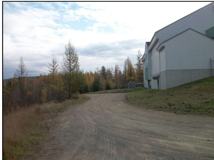
Accès porte No. 10
