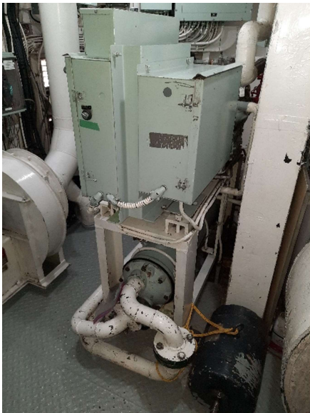
A.5 - Compresseur/Condenseur CVC côté tribord
