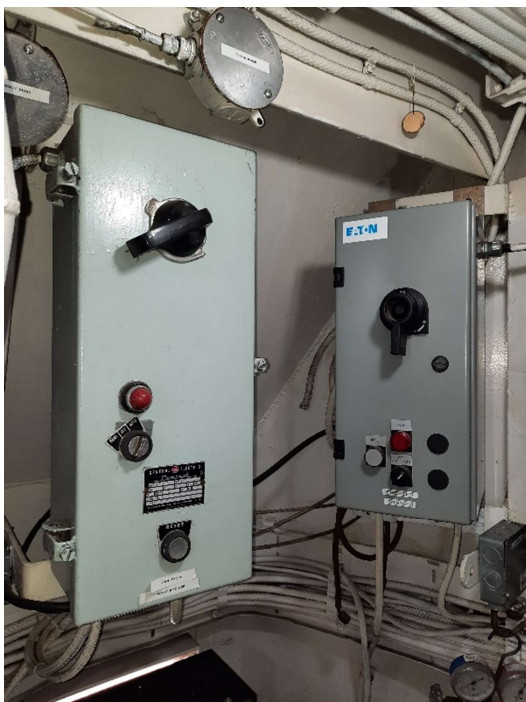
A.13 - Panneaux de commande des compresseurs de réfrigération situés au-dessus de la pile de compresseurs. Notez la cloison angulaire
