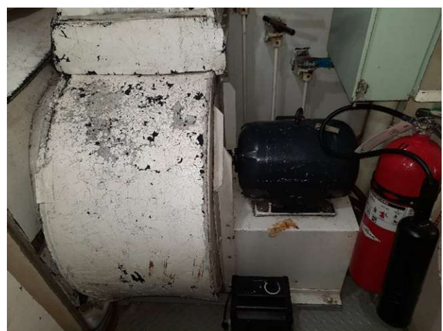
A.4 - Plénum et moteur du ventilateur CVC
