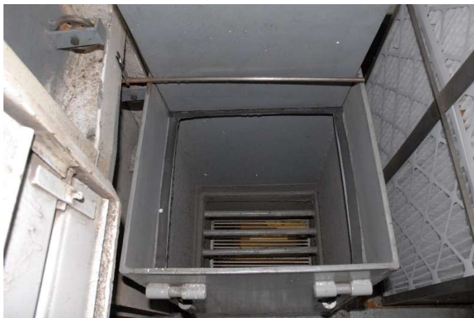
A.9 - Conduit de plancher pour le retour d'air de la CTA
