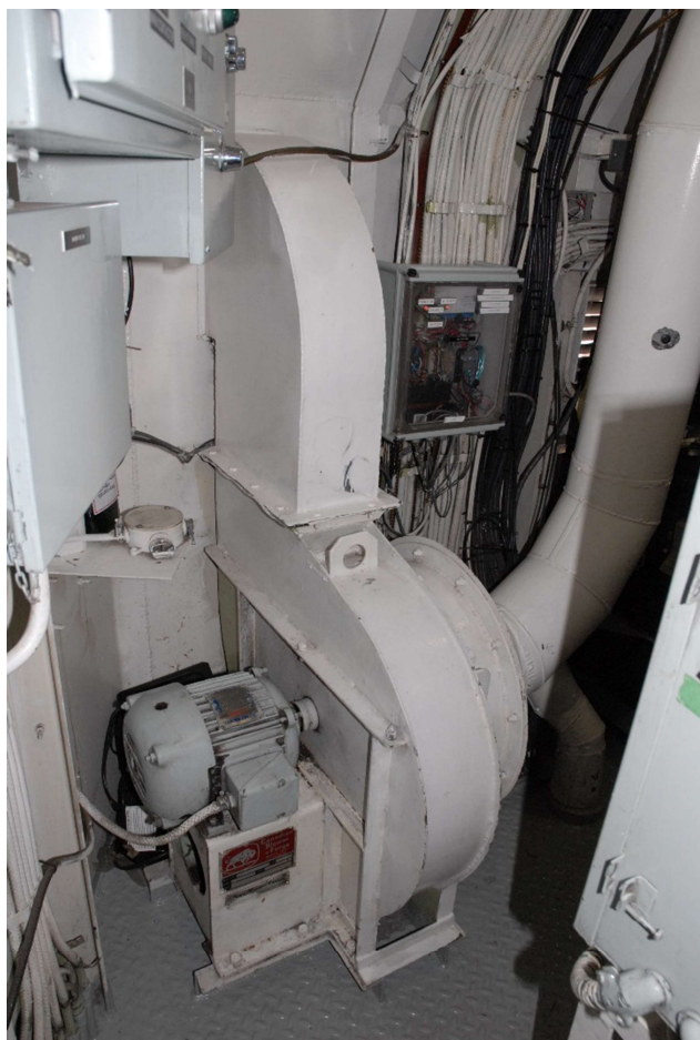
A.3 - Ventilateur d'extraction des toilettes vu de
