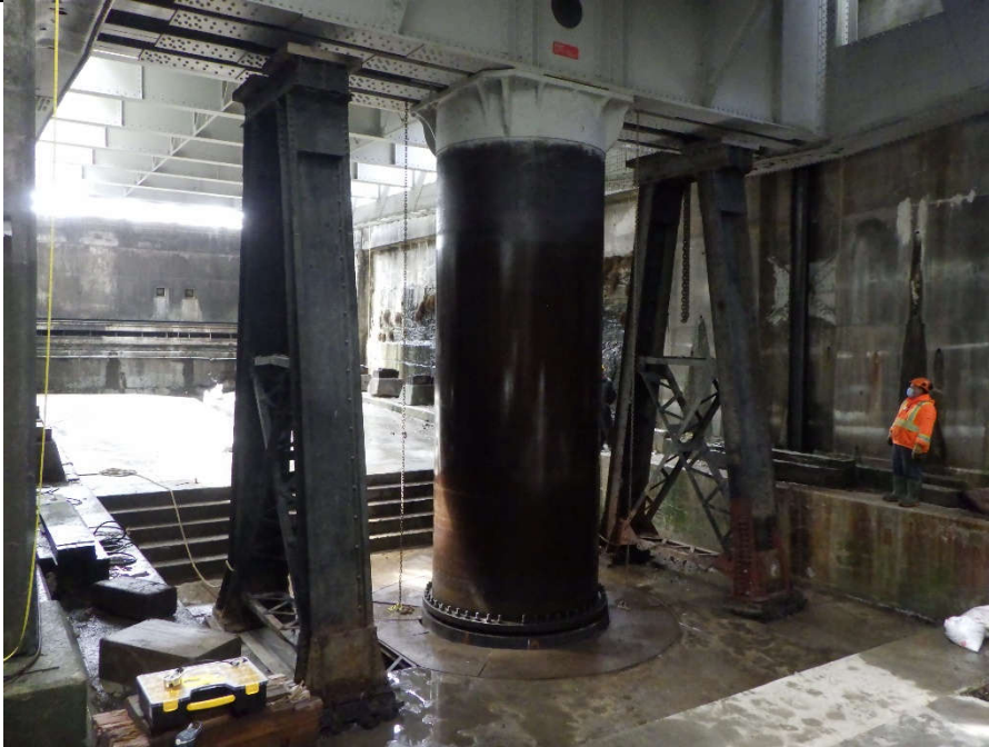
Photo 7. Bac d'embarcation reposant sur les colonnes de support pour l'hiver. À noter, le diamètre du cylindre principal est de 90 pouces
