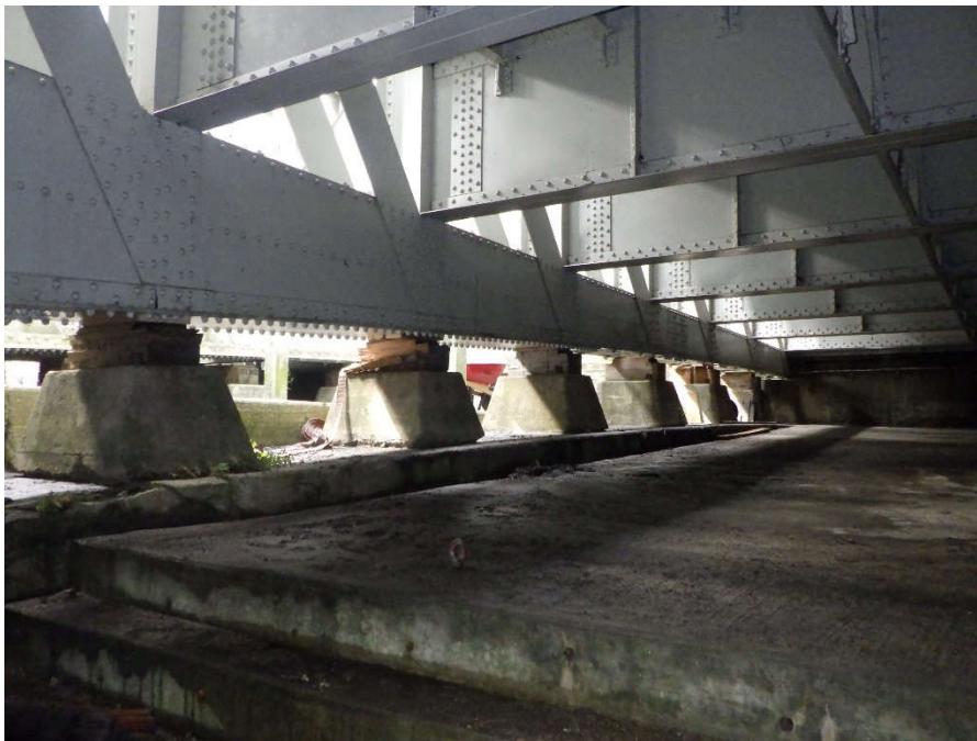
Photo 6. Sas nord reposant sur les blocs d'appui
