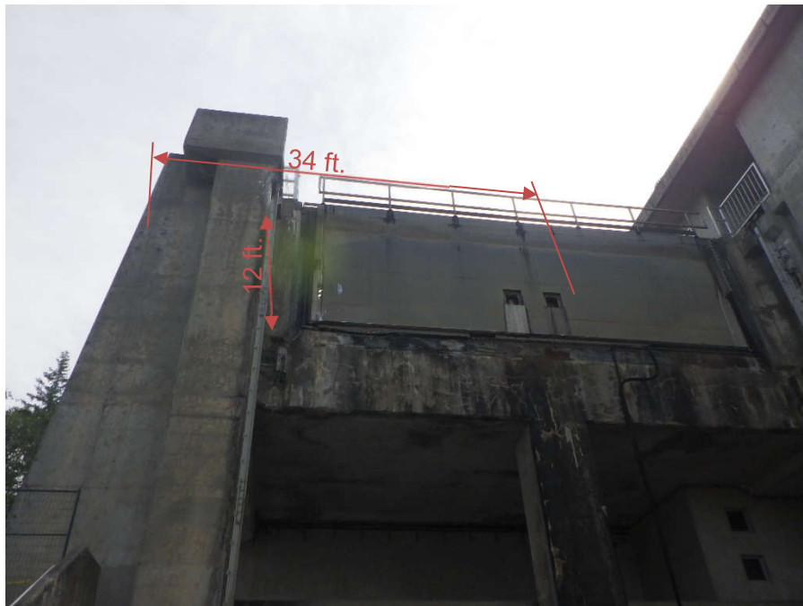
Photo 4. Sas nord – vue à l'échelle de la porte de la partie supérieure
