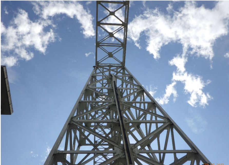
Photo 1. Sas nord, rail de guidage sud
