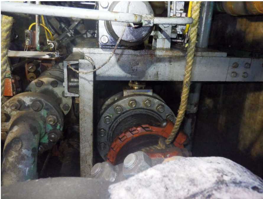
Photo 10. Vanne d'intercommunication. Dimension nominale du tuyau d'intercommunication : 12 pouces
