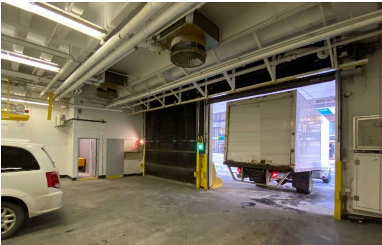
Photo 3: Photo de la porte du quai de chargement prise de l'intérieur
