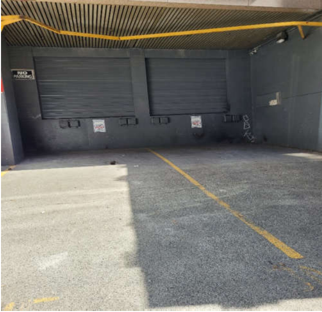
Photo du quai de chargement
