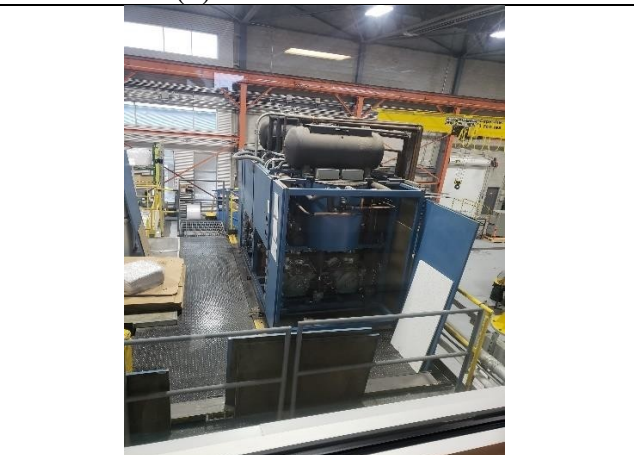
Photo 6 – Dessus de la chambre existante (trousse de compresseur 2)
