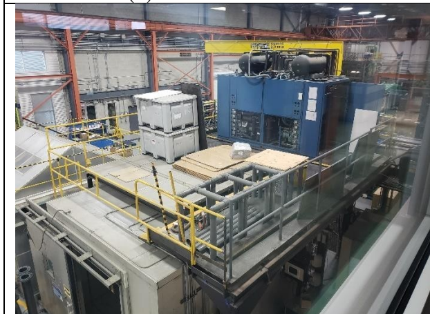
Photo 5 – Dessus de la chambre existante (trousse de compresseur 1)
