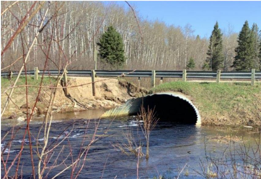
Le km 26 comporte deux voies de circulation au-dessus de la crique Jackfish. Construite en 1970, une voûte elliptique en tuyau de tôle d'acier ondulée à feuilles multiples de 5,550 m de large x 2,440 m de haut x 11 m de long a été utilisée avec un mur de tête en béton coulé sur place. Photo de l'état actuel :
