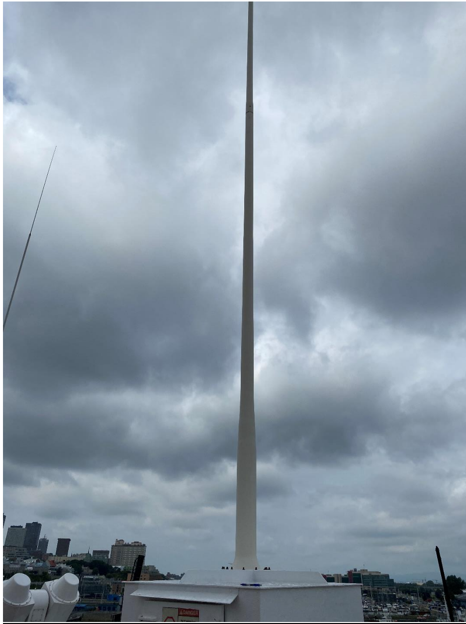
Figure 18.8-1 : Antenne du NDB sur le dessus de l'enceinte
