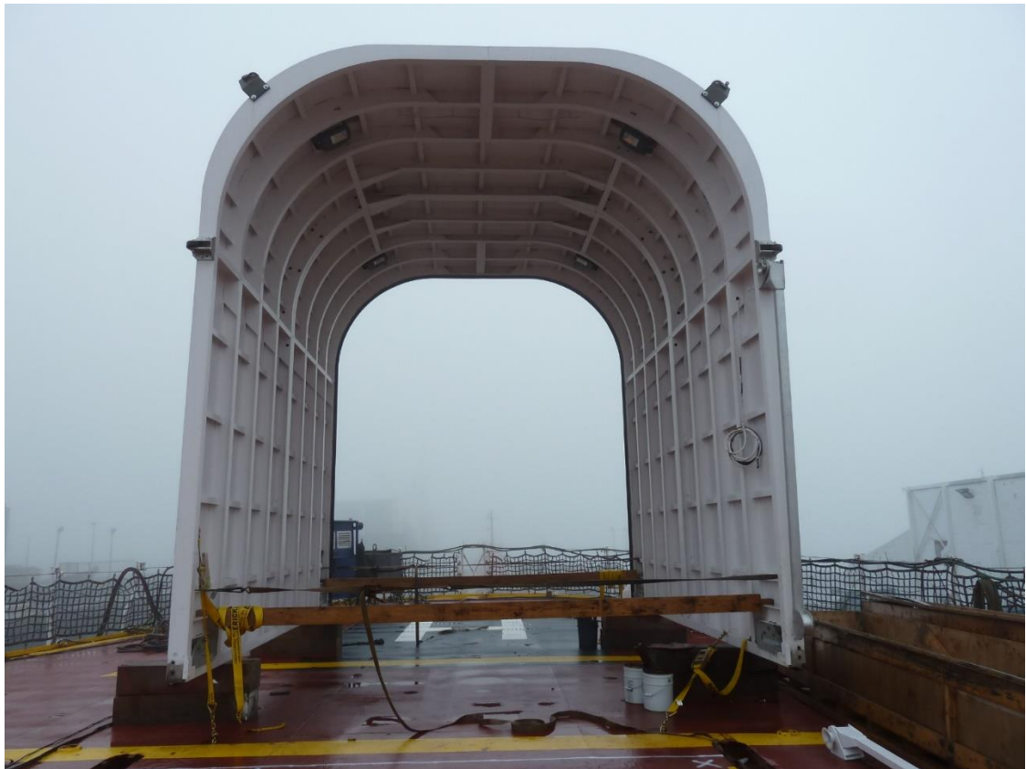
Figure 16.6.1-Photo d'une section du hangar prête à être soulevée
