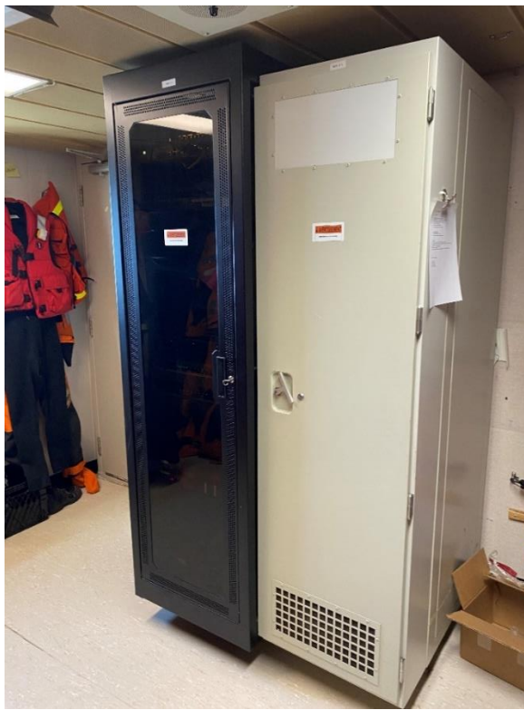
Figure 18.4-1 : Bâti 1 (TI) et bâti 2 (fibre optique) à enlever
