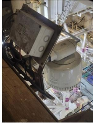
3.60.2.6. Caméra inférieure bâbord de la salle des machines avant – Axis Q1785-LE : La caméra inférieure bâbord de la salle des machines doit être installée dans l'espace de la salle des machines avant, du côté bâbord inférieur, pour remplacer la caméra Samsung actuelle. Cette caméra doit être fixée au support existant au moyen de la monture fournie avec la caméra.
