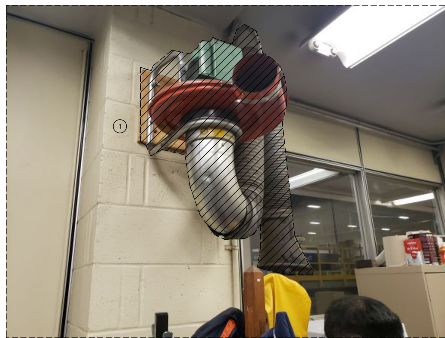
2 PHOTO NO 1 – RETRAIT DU VENTILATEUR D'ÉCHAPPEMENT EXISTANT MO2 ÉCHELLE = NON À L'ÉCHELLE
