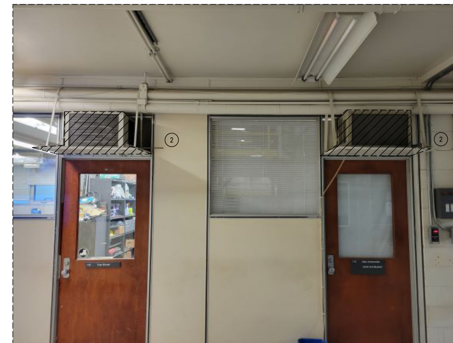
3 PHOTO NO 2 – RETRAIT DES CLIMATISEURS DE FENÊTRE EXISTANTS MO2 ÉCHELLE = NON À L'ÉCHELLE
