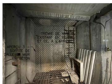
APERÇU N° 3 - MUR EN BÉTON, AU REZ-DE-CHAUSSEE / POUTRE DE DALLE, AU NIVEAU DU SOUS-SOL - APERÇU DE LA DÉLAMINATION ET DES FISSURES.
