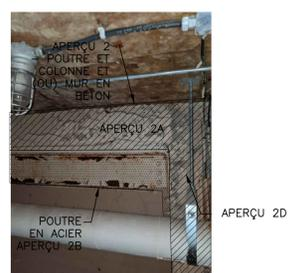
APERÇU 2 - MUR EN BÉTON AU SOUS-SOL / COLONNE AU REZ-DE-CHAUSSEE / POUTRE DE DALLE AU NIVEAU DU SOUS-SOL, DES POINTS DE VUE DE LA DÉLAMINATION ET DES FISSURES, POUTRE EN ACIER EN DESSOUS DE LA POUTRE DU REZ-DE-CHAUSSEE EN BÉTON, AUX FINS D'ÉTABLISSEMENT DE LA VALEUR DE CORROSION DE L'ACIER.
