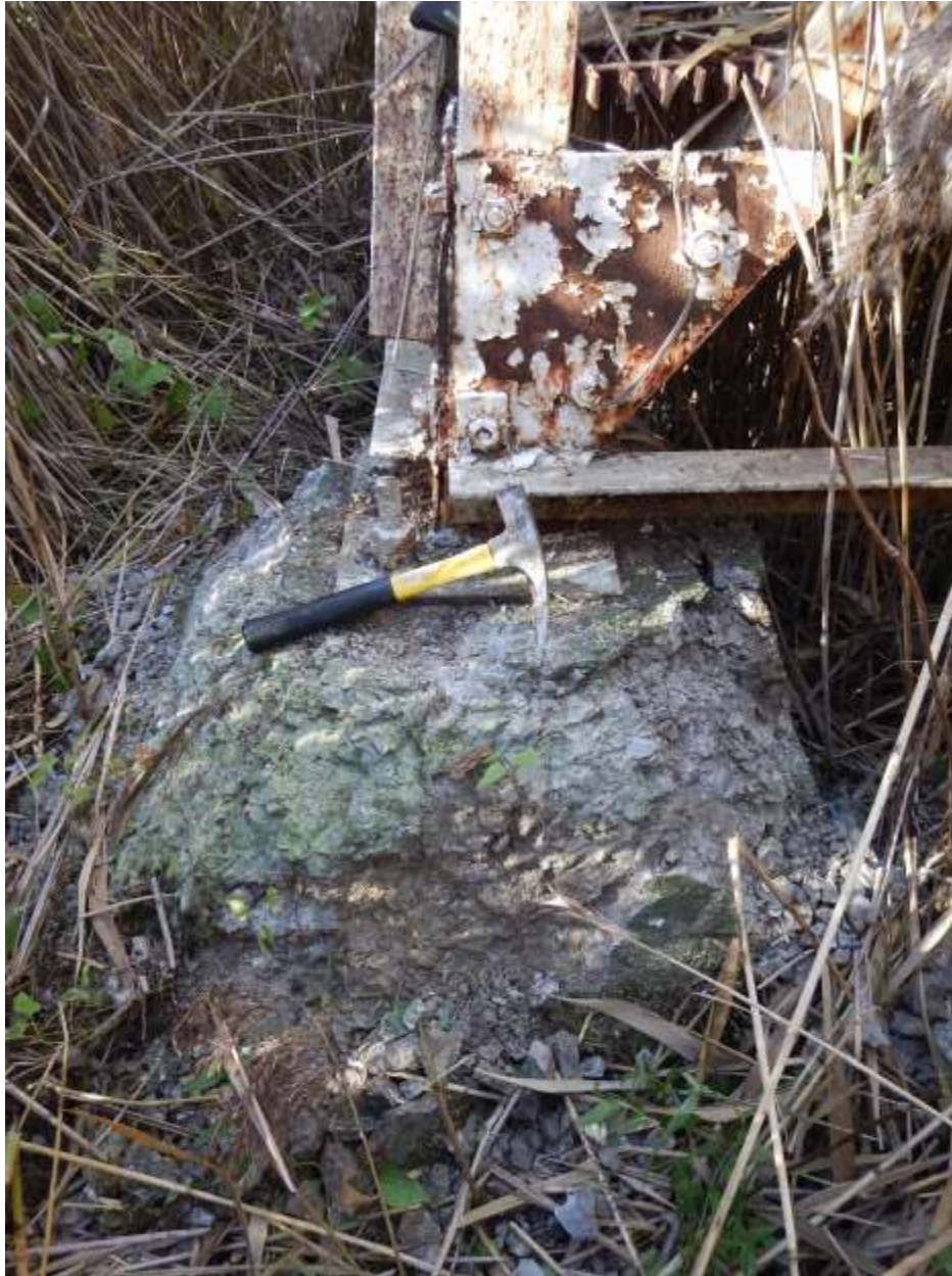
Figure 4 – Exemple de fondation en béton existante.
