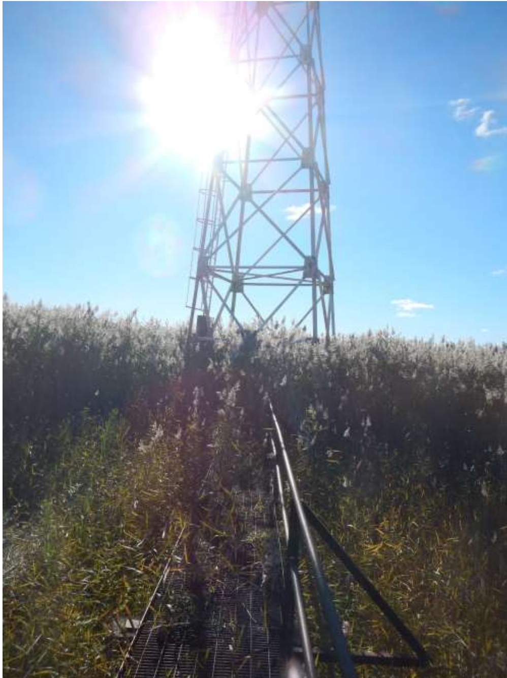
Figure 5 – Exemple de passerelle existante.
