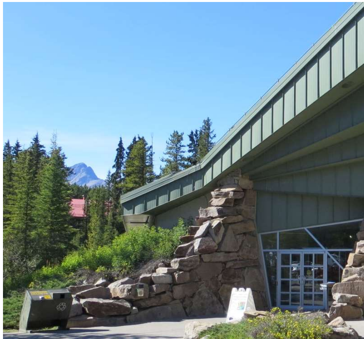
Figure 5. Image du lieu d'installation au Centre d'accueil de Lake Louise. L'appareil sera installé là où se trouvent les poubelles. Endroit sans courant alternatif.
