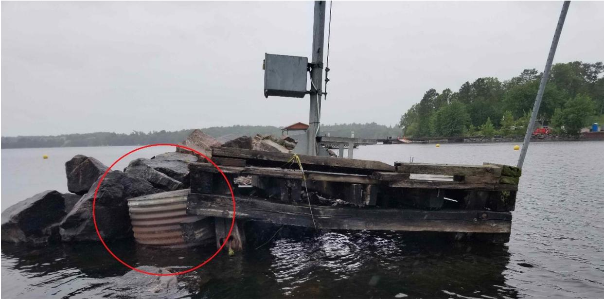
**Figure 2 : Quai en bois existant et fondation en béton abandonnée**
