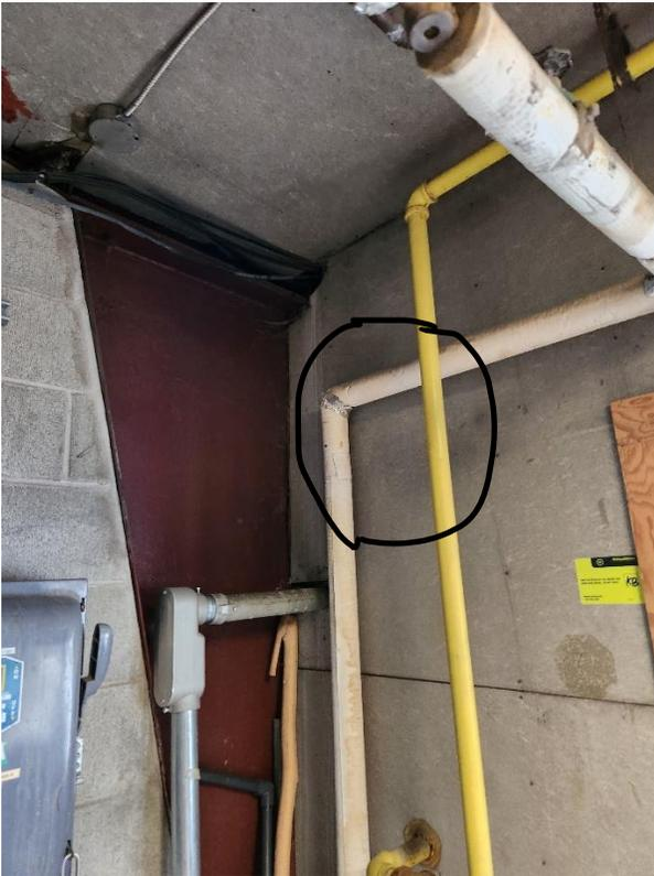
Pâte cimentaire du tuyau de chauffage retiré par AAC
