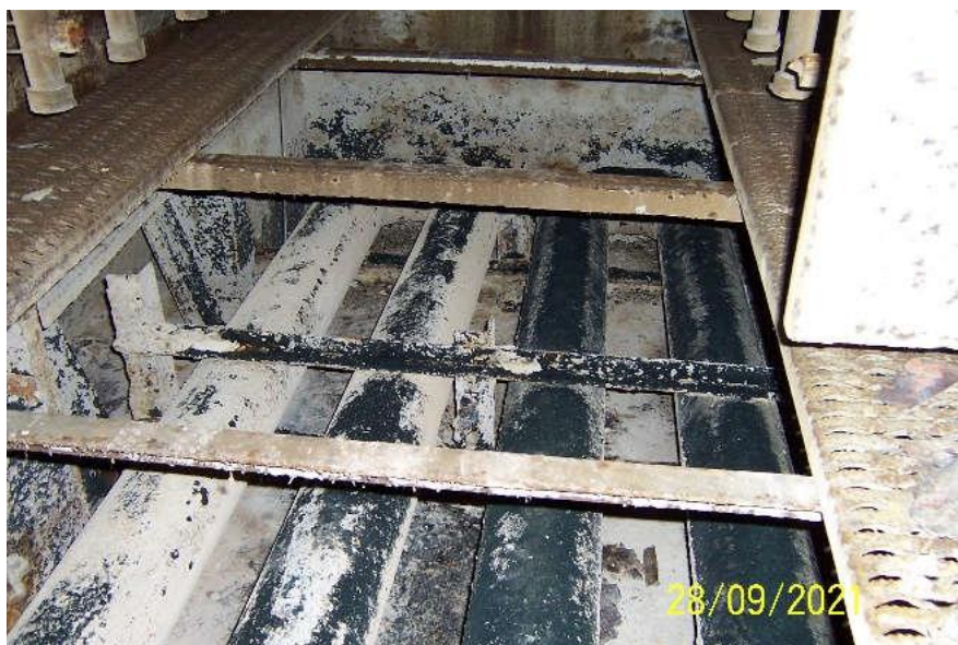
Photo 2 - Intérieur de l'unité 1 (Stage #1) Partie basse
