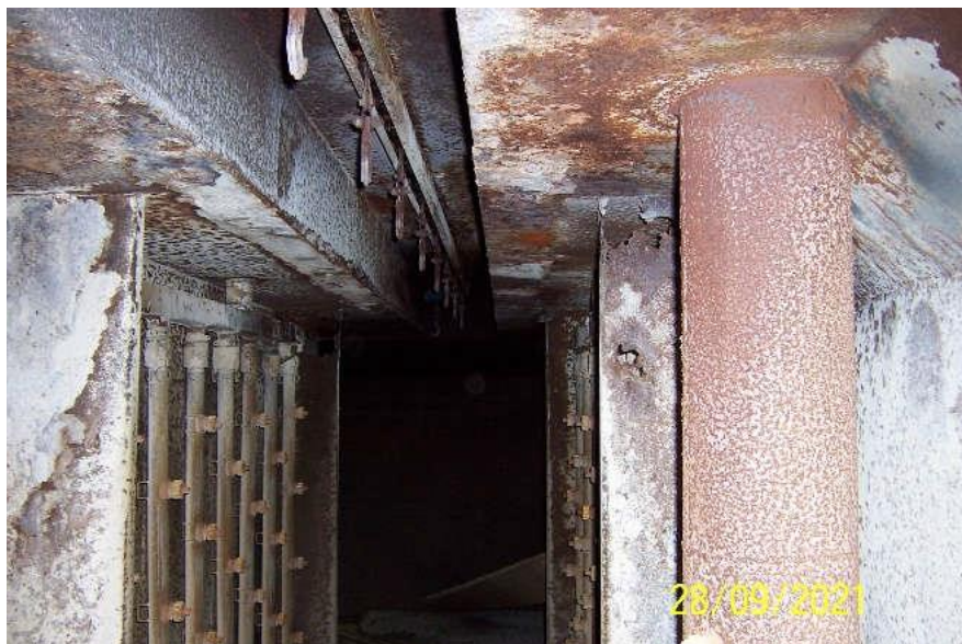
Photo 1 - Intérieur de l'unité 1 (Stage #1) Partie haute
