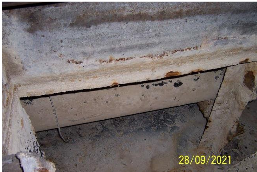
Photo 3 - Bassin de l'unité 1 (Stage #1)
