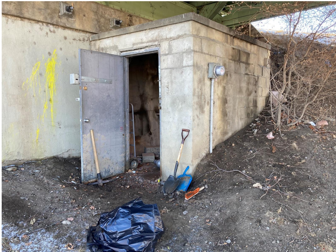
Figure 1 : Structure existante – Elle sera enlevée par un autre entrepreneur
