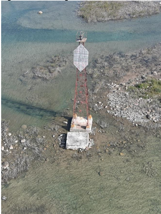
Figure 3 : Tour d'alignement avant LL5416 existante
