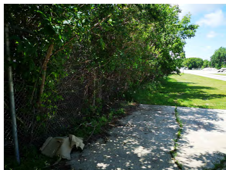
2 VÉGÉTATION TYPIQUE ET CLÔTURE À MAILLES LOSANGÉES AU NOUVEL ACCÈS PROPOSÉ
