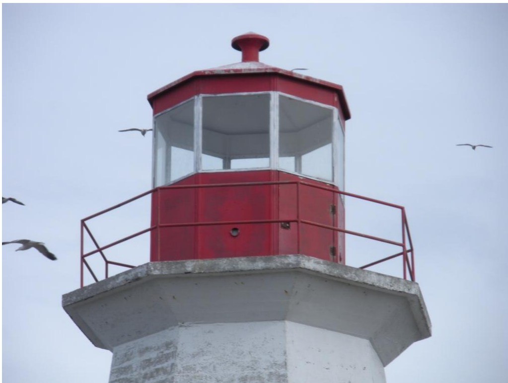
Photo 3 : Vue du balcon en béton et de la coupole en acier
