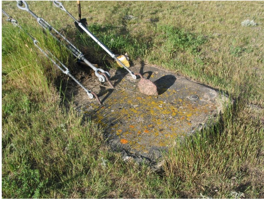
Figure 4. Massif d'ancrage en béton du côté départ sur la rive gauche
