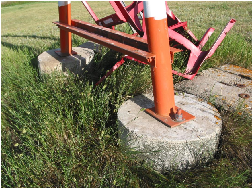
Figure 5. Piles et semelles de béton du côté départ sur la rive gauche
