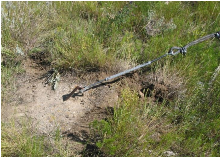
Figure 9. Hauban sur le côté du montant fixé au socle de béton du côté arrivée sur la rive droite
