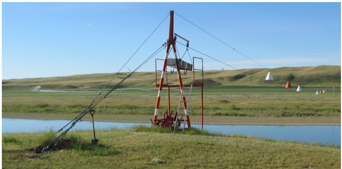
Figure 3. Infrastructure actuelle du côté départ sur la rive gauche et balises pour les aéronefs
